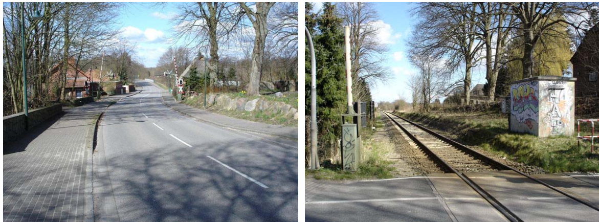
Abb. 19 und 20: Ein neuer Bahnsteig in Achterwehr kann am Bahnübergang an der Dorfstraße errichtet werden
