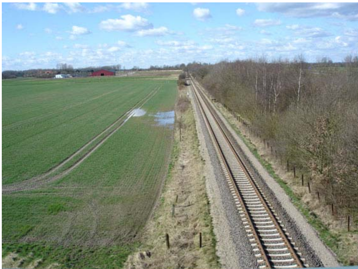
Abb. 22: Blick von der Brücke Rolfshörner Weg: Im Vordergrund die Lage des neuen Bahnsteigs, im Hintergrund das im Aufbau befindliche interkommunale Gewerbegebiet
