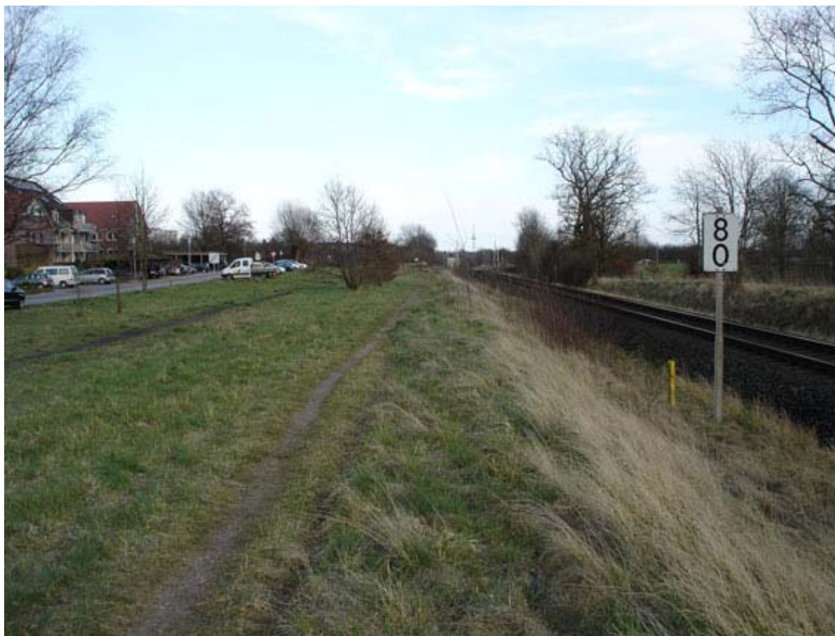
Abb. 14: Das ehemalige Bahngelände in Melsdorf befindet sich in Gemeindebesitz und bietet ausreichend Platz für Verknüpfungsanlagen. Im Hintergrund der Bahnübergang Rotenhofer Weg, links die Bahnhofstraße.
