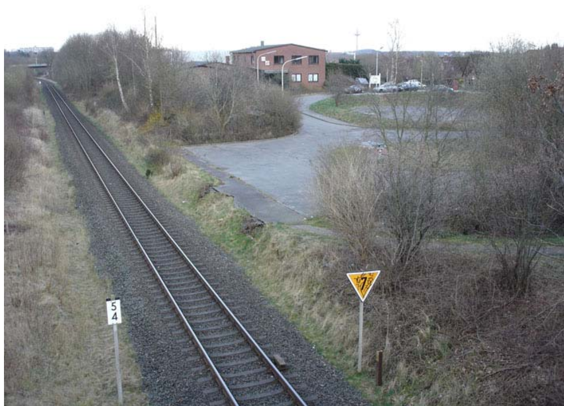
Abb. 9: Blick von der Brücke Russeer Weg auf die Lage des neuen Bahnsteigs an der alten Buskehre. Im Vordergrund rechts die alte Fahrradrampe, im Hintergrund die Zufahrt vom Köpenicker Weg.
