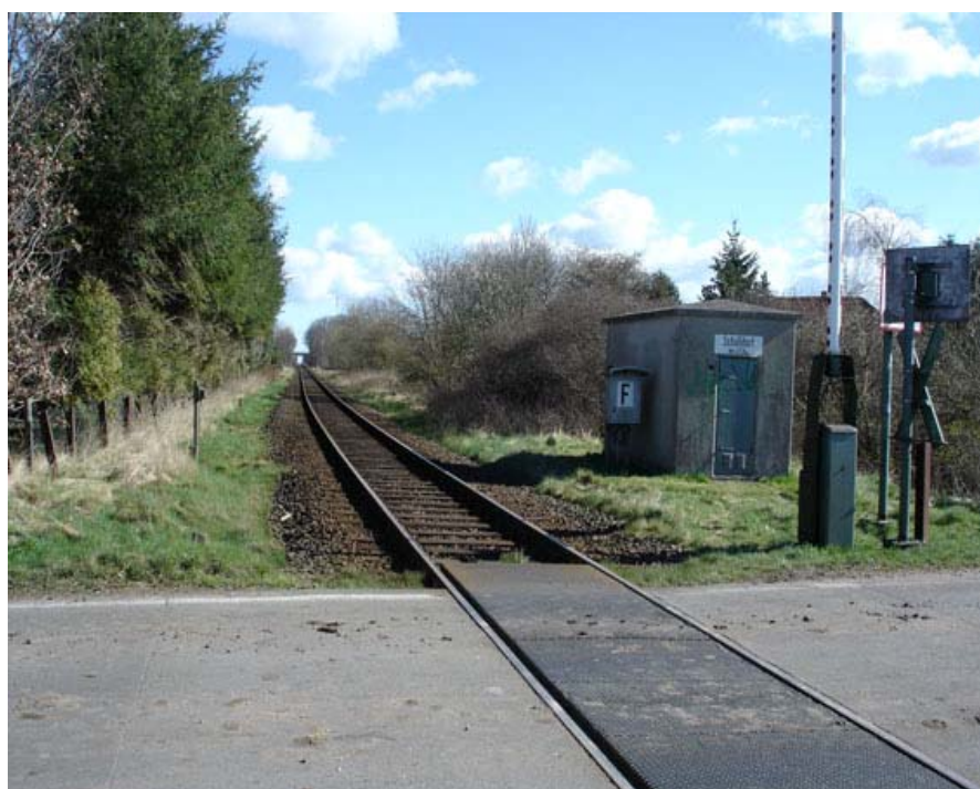
Abb. 27: Hinter dem Schalthaus des Bahnübergangs kann der neue Bahnsteig an der Strecke in Blickrichtung Kiel errichtet werden.
