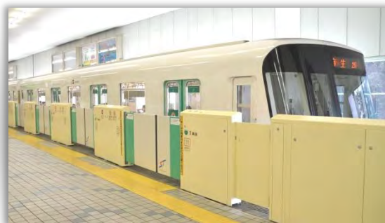
南北線真駒内駅ホーム
