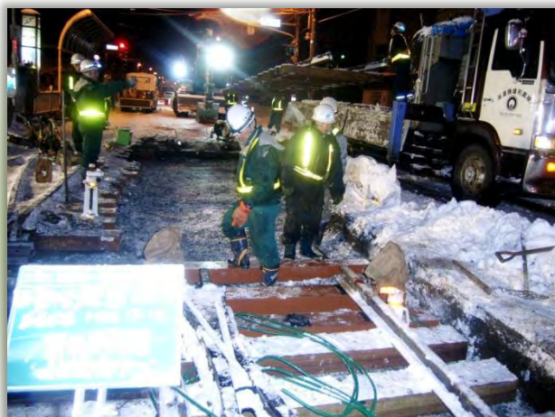
工事の様子（南16条西7丁目）
