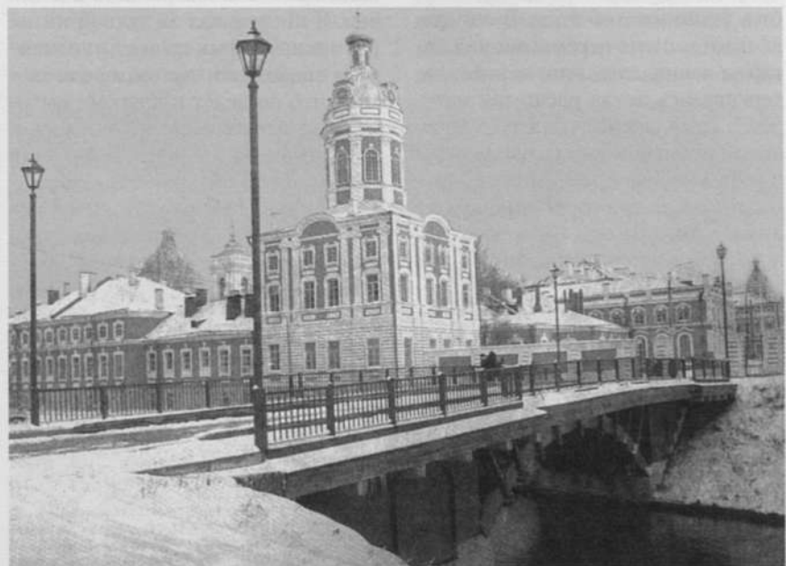
Второй Лаврский мост через р. Монастырку
