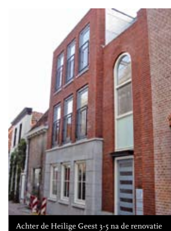
Achter de Heilige Geest 3-5 na de renovatie
