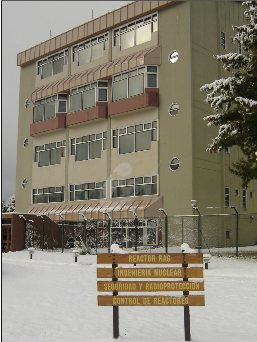
Imagen del edificio del reactor nuclear RA-6 en el predio del Centro Atómico Bariloche de la CNEA.
