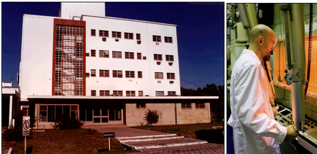
Imagen izquierda: edificio del reactor nuclear RA-3. Imagen derecha: Planta de Producción de Radioisótopos del Centro Atómico Ezeiza.
