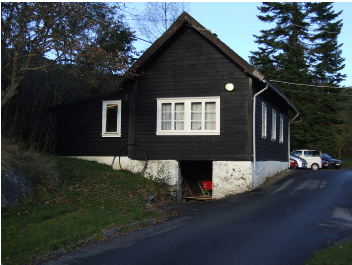
Vaktmesterbod mot sørvest. Foto: Leif Anker, Forsvarsbygg.
