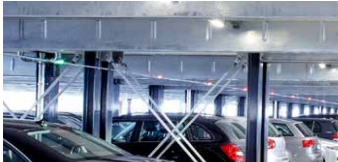
Bei komplexen Parkhäusern kommen Parkleitsysteme mit Einzelplatzüberwachung zum Einsatz.
