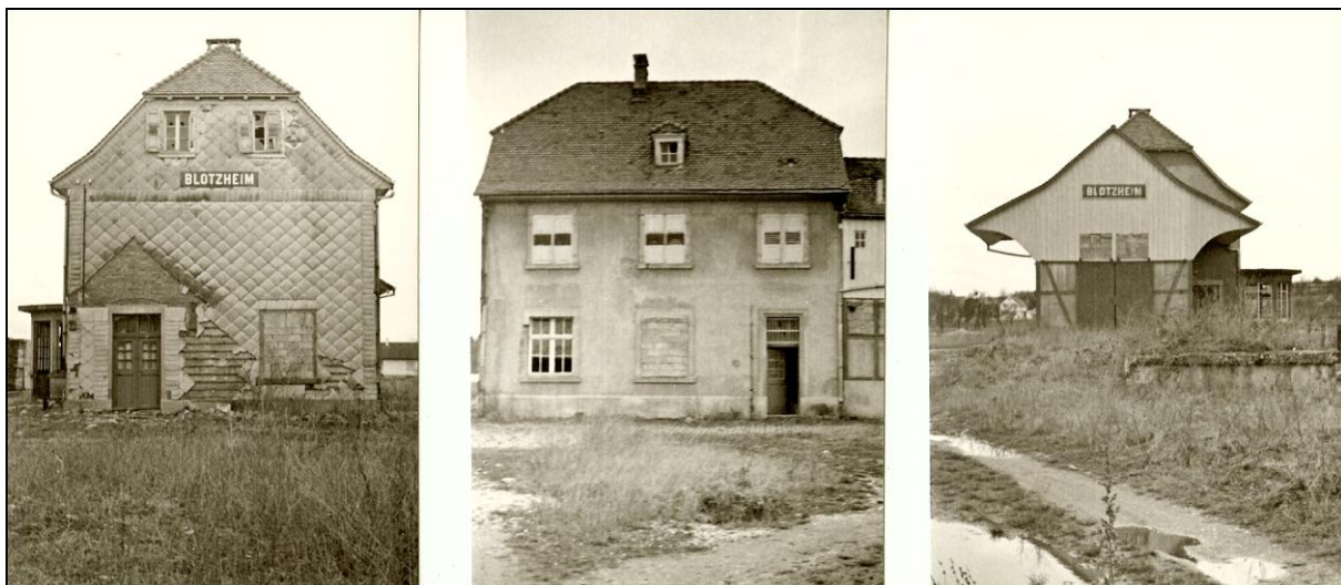
La gare de Blotzheim (juste avant démolition)
