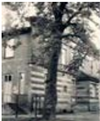
Das Institutsgebäude Fallada-Straße 2
