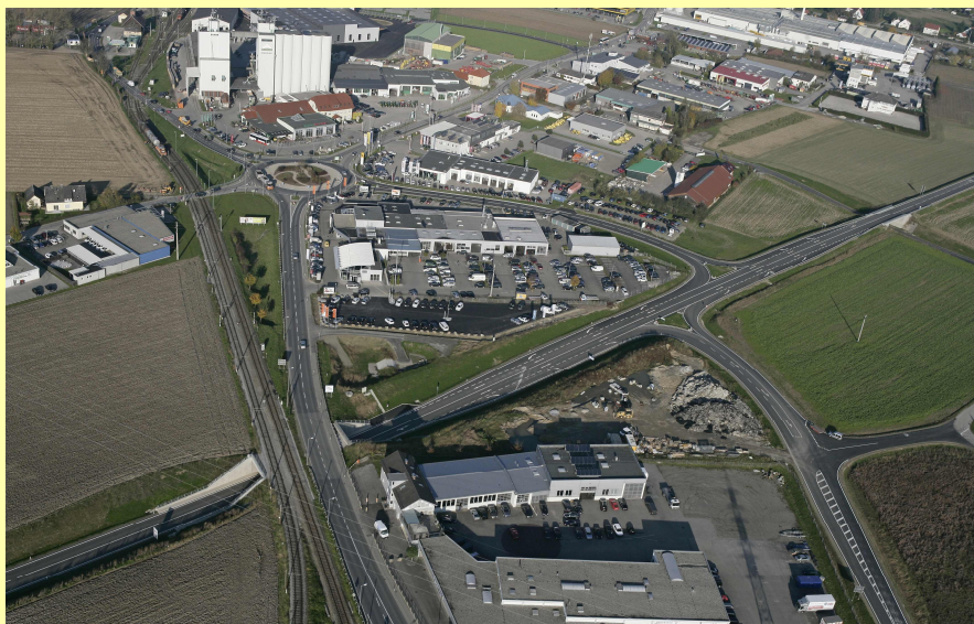
(Abb.: Umfahrung Eferding 1. Teil – Unterführung B134/LILO/OBB)
