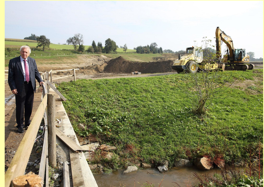
(Abb.: LHStv. Hiesl beim Baustellenbesuch im Oktober 2014)
