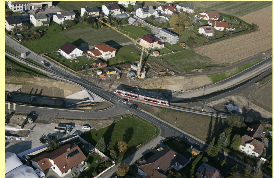
(Abb.: Umfahrung Eferding 1. Bauabschnitt – Überführung L531/LILO)
