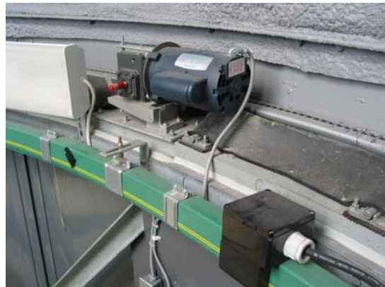
Bild .16 Motor för att rotera kupolen
