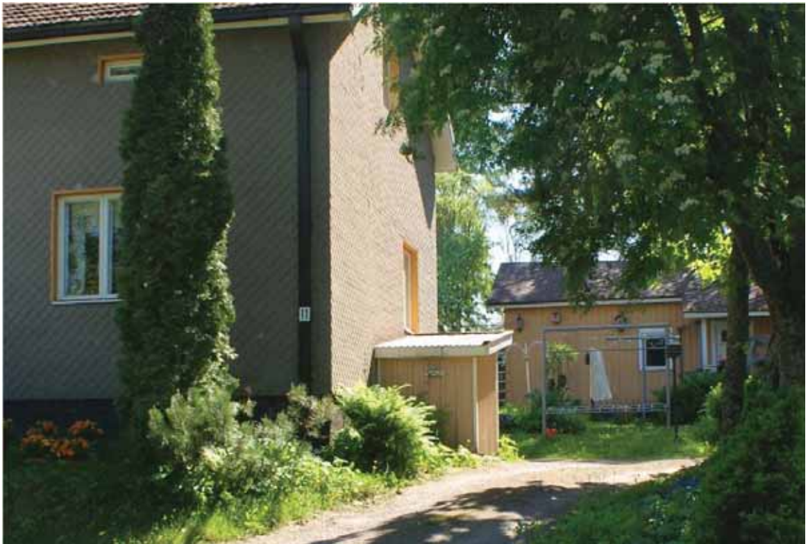
Kuva: Alueen lautaverhoiltujen rakennusten joukossa on yksi kuviorappauksella verhoiltu talo. Pihan perällä on talon kanssa samalta aikakaudelta peräisin oleva puinen talousrakennus. Talon päädyssä on kellarin sisäänkäynti.
