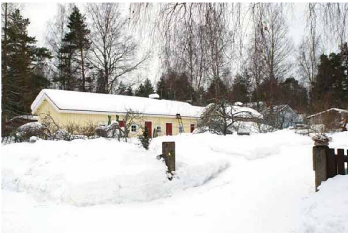
Kuvat: 1940-luvulla rakennettuja talousrakennuksia Urheilutiehen rajautuvilla tonteilla. Ne ovat tyypillisesti puisia, pitkänomaisia, kapeita ja melko jyrkkäharjaisia.
