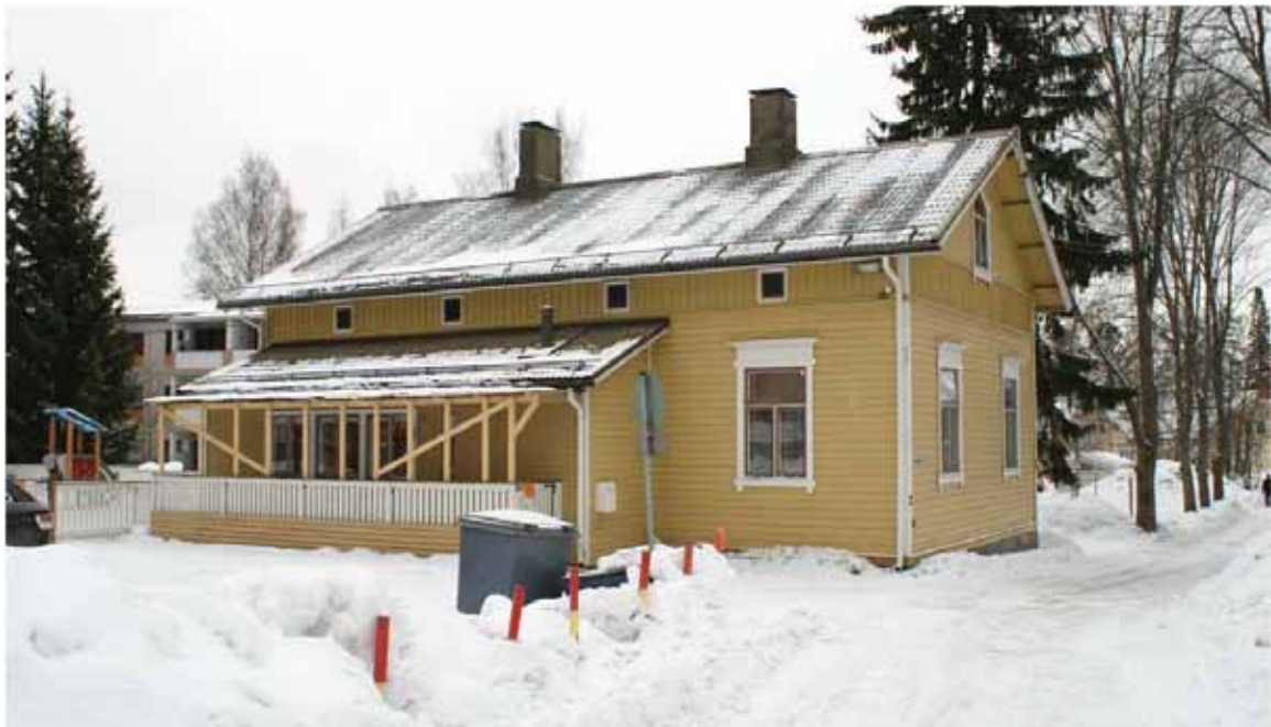
Kuva: Vihriälän asuintalo pohjoisesta.
