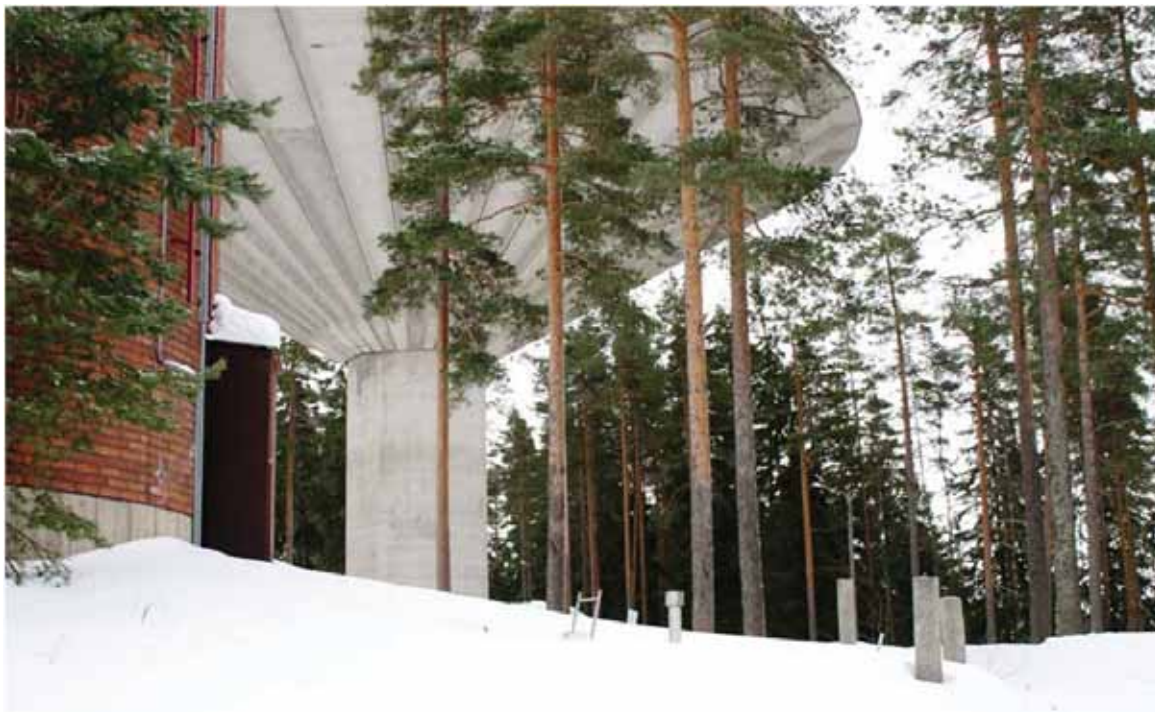
Kuva: Ylöjärven vesitornit; vasemmalla näkyy 1960-luvun lieriötornin tiiliseinää, takana 1980-luvun kartiotorni.
