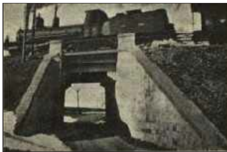
Pont de Viggen, 1894, (Suisse)
