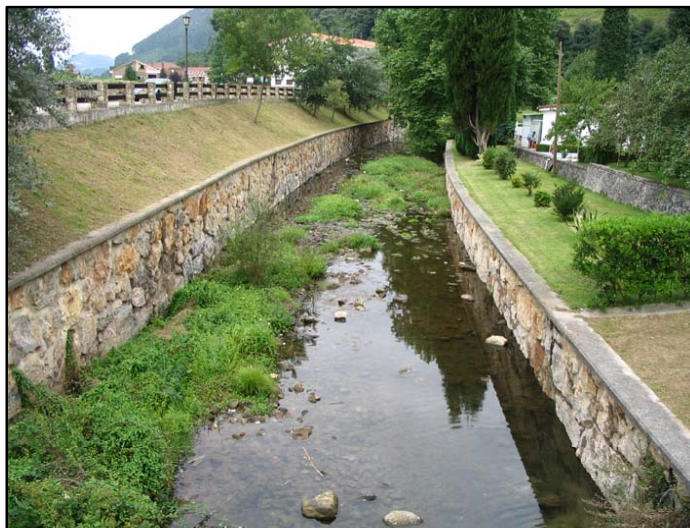
Figura 4.25. Zona encauzada del río Escudo en su tramo de cabecera.
