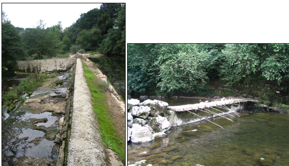
Figura 4.24. Azudes en el tramo final del río Nansa.
