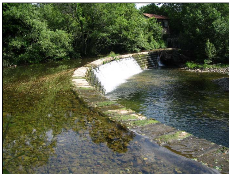
Figura 4.46. Azud situado en la localidad de Liérganes.
