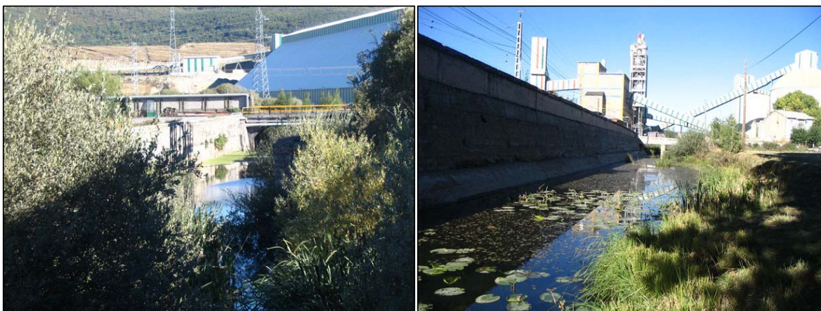
Figura 4.67. Encauzamientos del río Camesa a su paso por Mataporquera.
