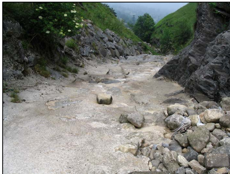
Figura 4.45. Fijación del lecho en el tramo alto del Miera.
