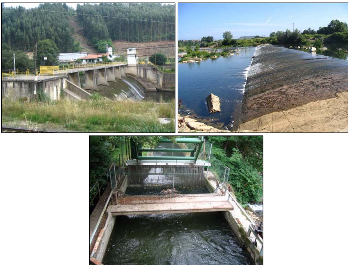
Figura 4.29. Azud junto al área industrial de Bridgestone (Puente San Miguel) para la derivación de caudal a la empresa Sniace, azud de Solvay (Viveda), en el límite con la zona estuarina, y canal de derivación de la central hidroeléctrica de Santa Lucía.
