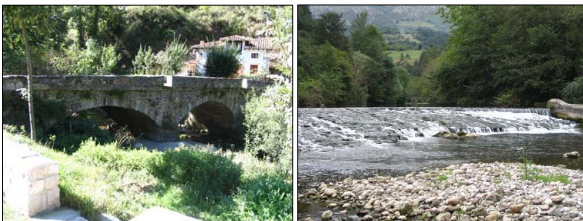
Figura 4.20. Puente sobre el río Deva en Cosgaya (izquierda) y azud en La Hermida (derecha).
