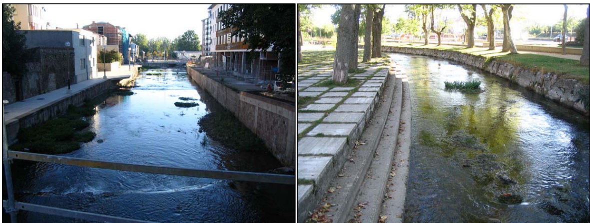
Figura 4.63. Canalización del río Ebro a su paso por Reinosa.
