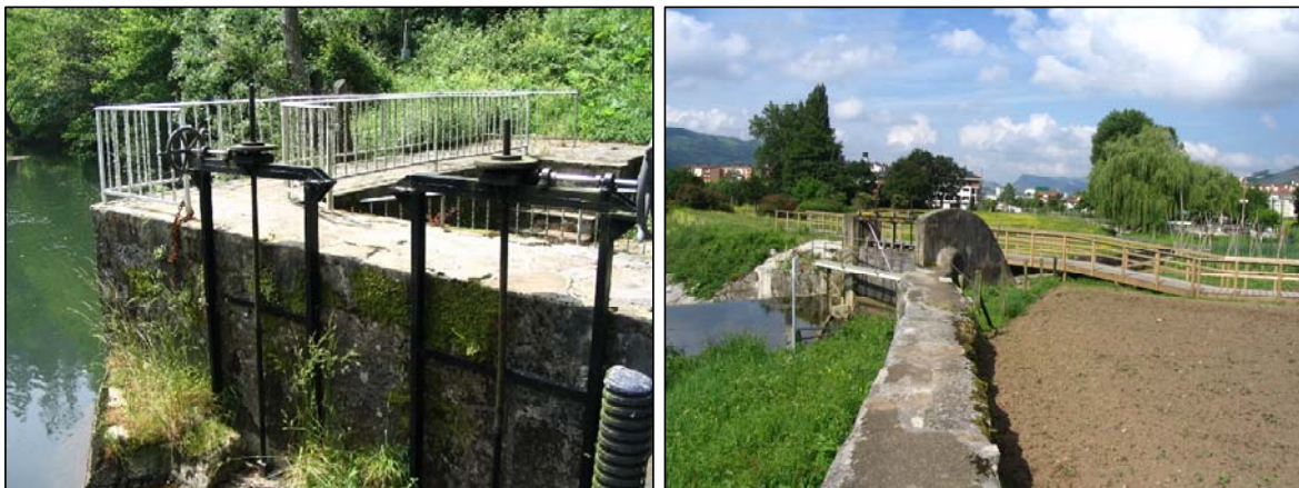
Figura 4.42. Punto de detención de caudal en Vega (Villafufre) y el correspondiente a la fábrica de la Nestle (derecha).
