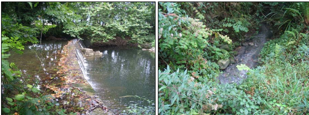
Figura 4.56. Azud y vertido de aguas residuales en el tramo bajo del Agüera.
