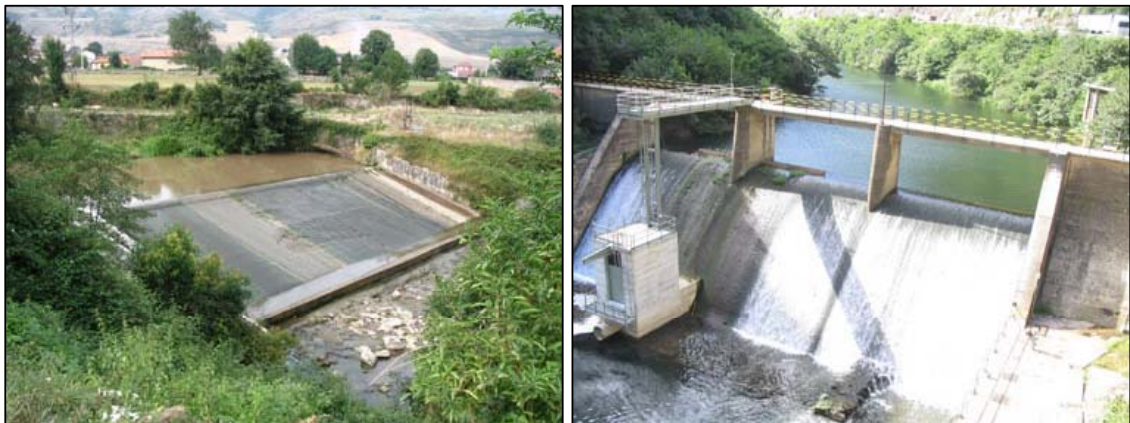
Figura 4.33 . Azud de abastecimiento de una central hidroeléctrica en Santa Cruz (Molledo) y embalse de los Corrales de Buelna (Arenas de Iguña).
