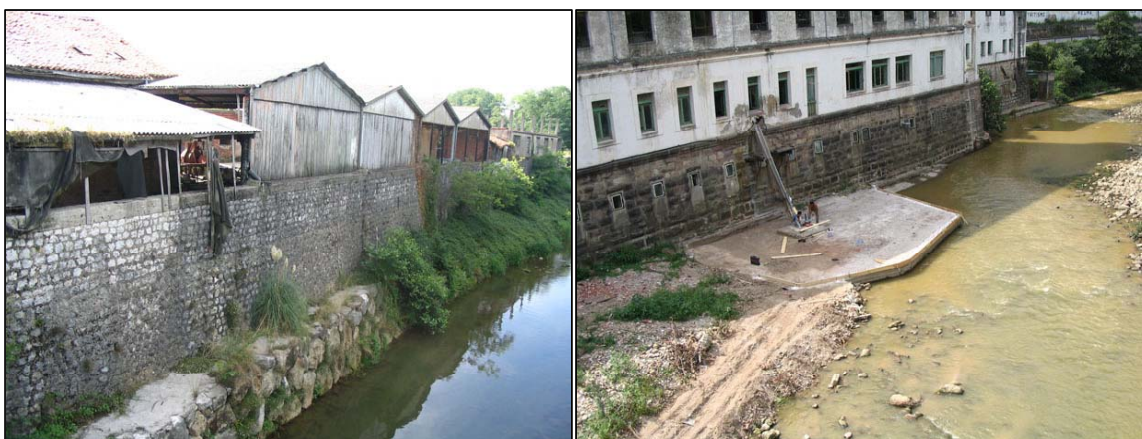
Figura 4.34. Encauzamiento de los márgenes a la altura de Torrelavega y fijación del lecho en Las Caldas.
