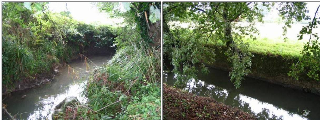
Figura 4.48. Zona del vertido de la depuradora y encauzamiento en Hazas de Cesto.
