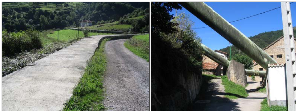
Figura 4.23. Canal de derivación siguiendo el trazado de la carretera e incorporación a la central hidroeléctrica de Rozadío.
