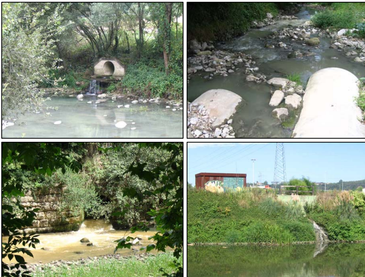
Figura 4.31. Vertidos de aguas residuales en el entorno de Los Corrales de Buelna y Torrelavega.
