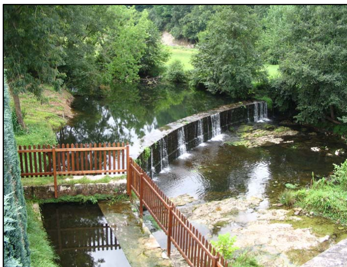
Figura 4.26. Azud y canal de derivación en el punto de toma de Las Cuevas (Roiz).
