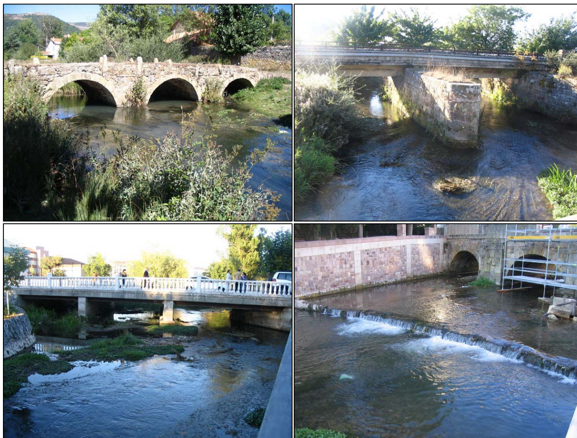
Figura 4.61. Algunos de los puentes existentes en la cuenca alta del río Ebro.
