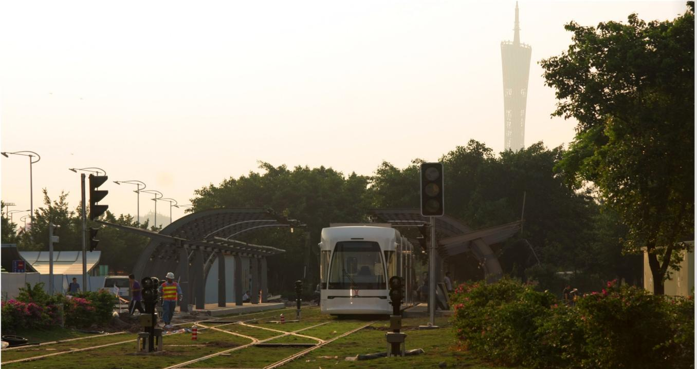
9月26日，海珠新型有轨电车会展中心东站送电成功！此举为试验段9月30日开通试运行奠定了坚实的基础。当晚19:00，完成对电缆、变电设备和整个车站供电系统的送电冲击试验和测试。22:00完成所有规定的测试项目，会展中心东站进入空载试运行的新阶段。
