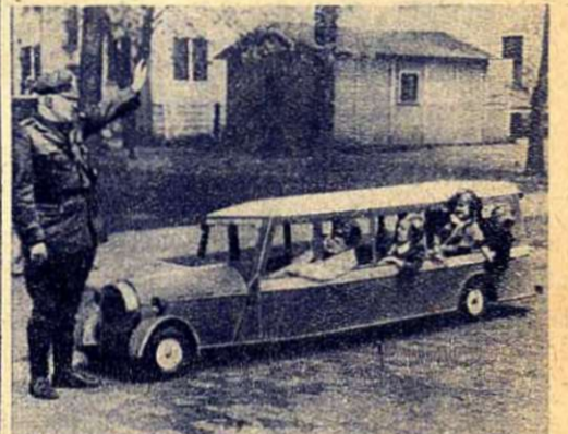
Детский автобус в США, перевозящий одновременно 9 ребят. Этот автобус делает до 30 км в час и набирает горючего на 90 км.
