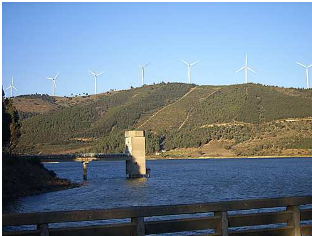
TOMADA DE ÁGUA (I)
