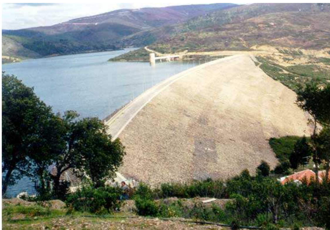
VISTA GERAL DA BARRAGEM (II)
