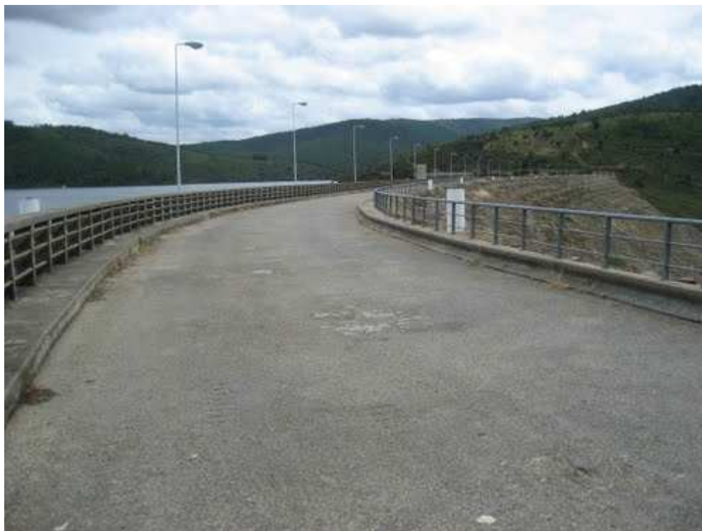
COROAMENTO DA BARRAGEM (I)
