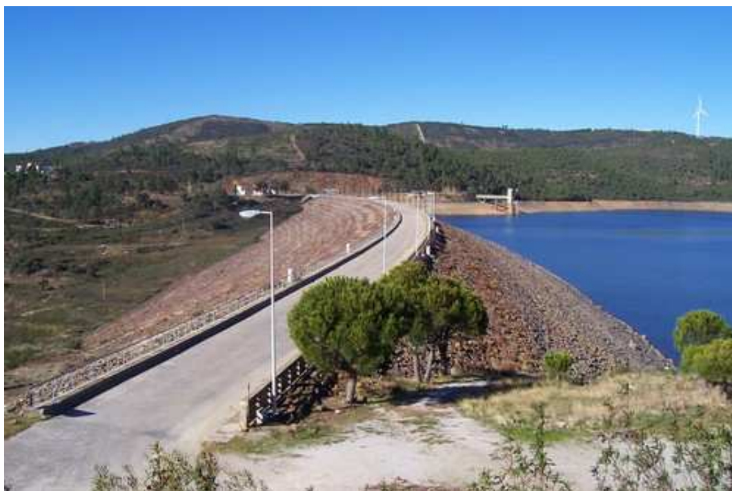
COROAMENTO DA BARRAGEM (II)
