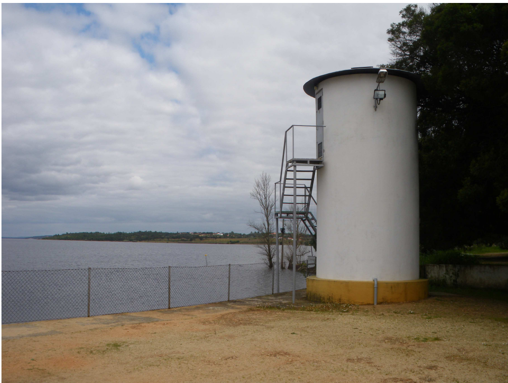
DESCARGA DE FUNDO (TORRE DE MANOBRA)
