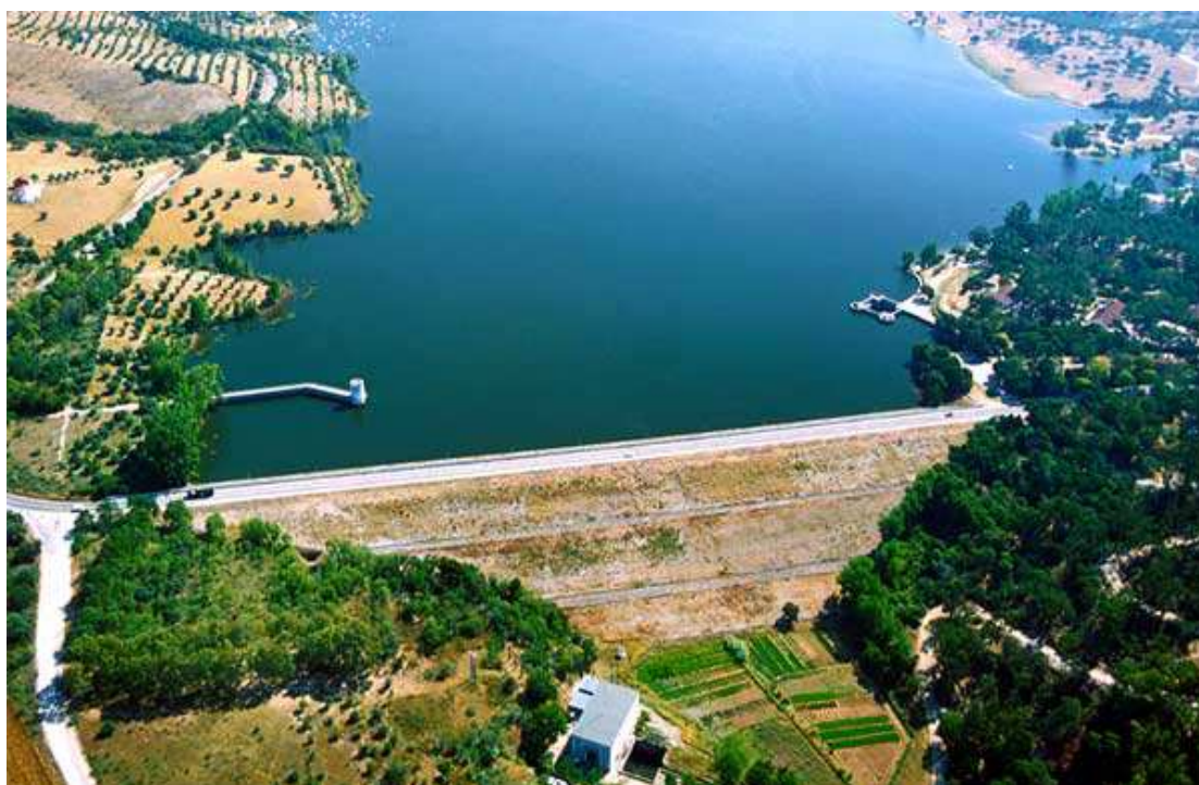
PARAMENTO DE JUSANTE
