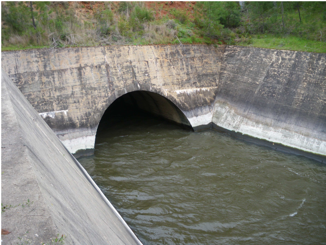
DESCARGA DE FUNDO (SAÍDA COMUM AO DESCARREGADOR DE SUPERFÍCIE)
