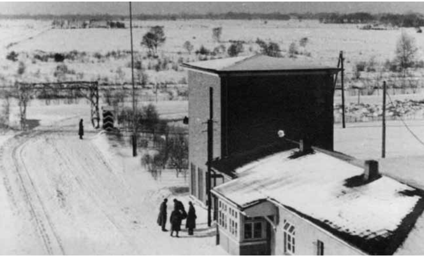
Lagereingang in Richtung Kanal (Johann Kortmann)
