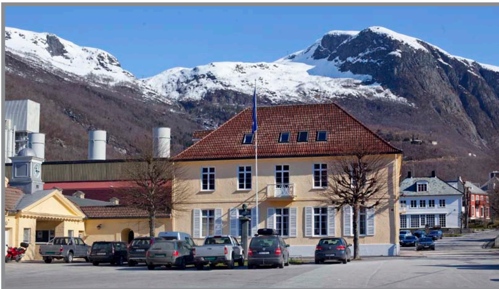
HAN SOM BYGDE BYEN: Ved fabrikkporten, på plassen framføre fabrikkens sitt administrasjonsbygg, står ein byste på høg sokkel med denne påskrifta: «Tilegnet direktør Sigurd Kloumann der grunnla og bygget dette sted.» Bysta av bilethoggar Dyre Vaa var ei helsing til direktøren frå høysangerfolket på 50-årsdagen hans i 1929.
