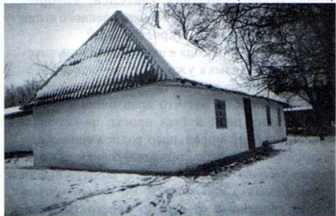
Молитвенный дом в с.Новая Гребля Калиновского района (дом —1937 года постройки)
