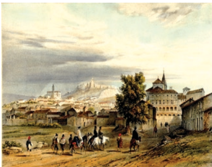
Vista General de Vélez-Málaga. Grabado de N Chapuy, 1830
