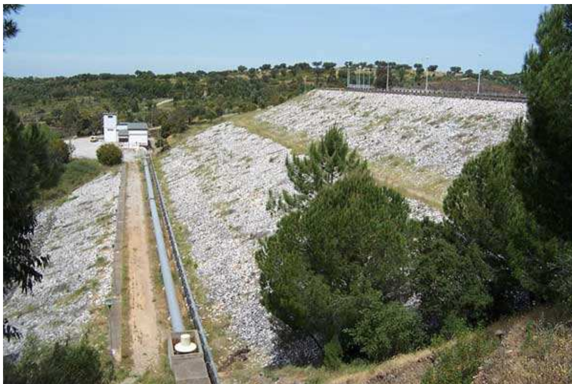
PARAMENTO DE JUSANTE
