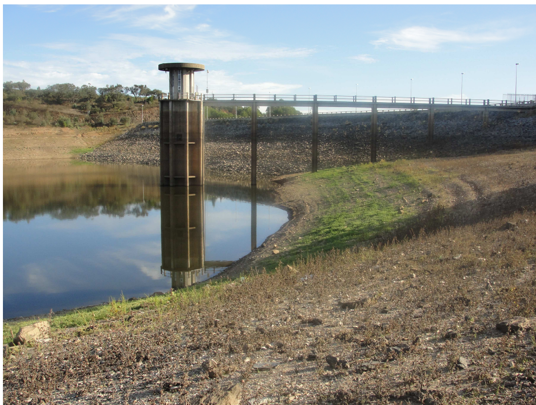
TOMADA DE ÁGUA
