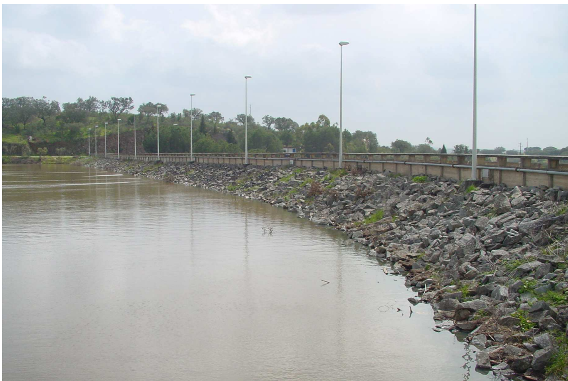
PARAMENTO DE MONTANTE
