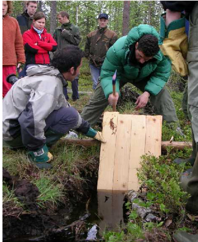
Figur 18. Tillverkning av tillfälligt däck inför hyggesbränningen på kursen Fire Management 1 sommaren 2004. En plastduk lades sedan mot plankorna av råspont och dammen tätades med torv.
