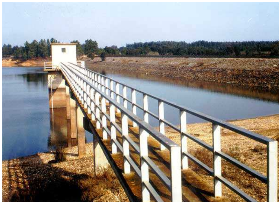
TOMADA DE ÁGUA E PARAMENTO DE MONTANTE
