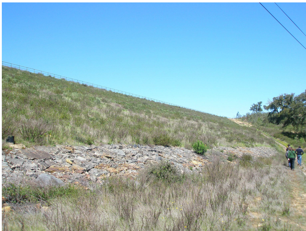
PARAMENTO DE JUSANTE
