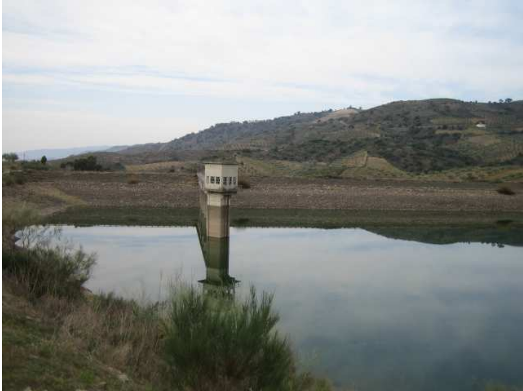
PARAMENTO DE MONTANTE
