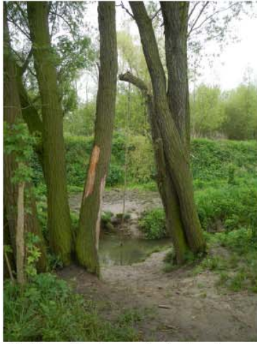
slibbekkens - slingertouw over beek met erosie
