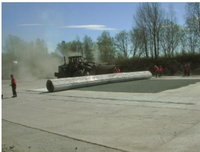
Kuva 14. Korjatun pommikuopan päällysteenä käytettävä alumiinimatto on nopea asentaa.
