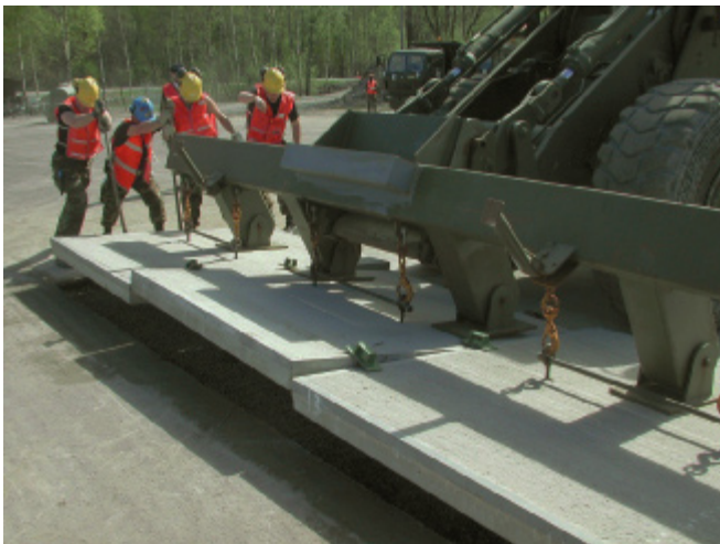
Kuva 13. Päällystäminen teräsbetonielementeillä (concrete slab)
