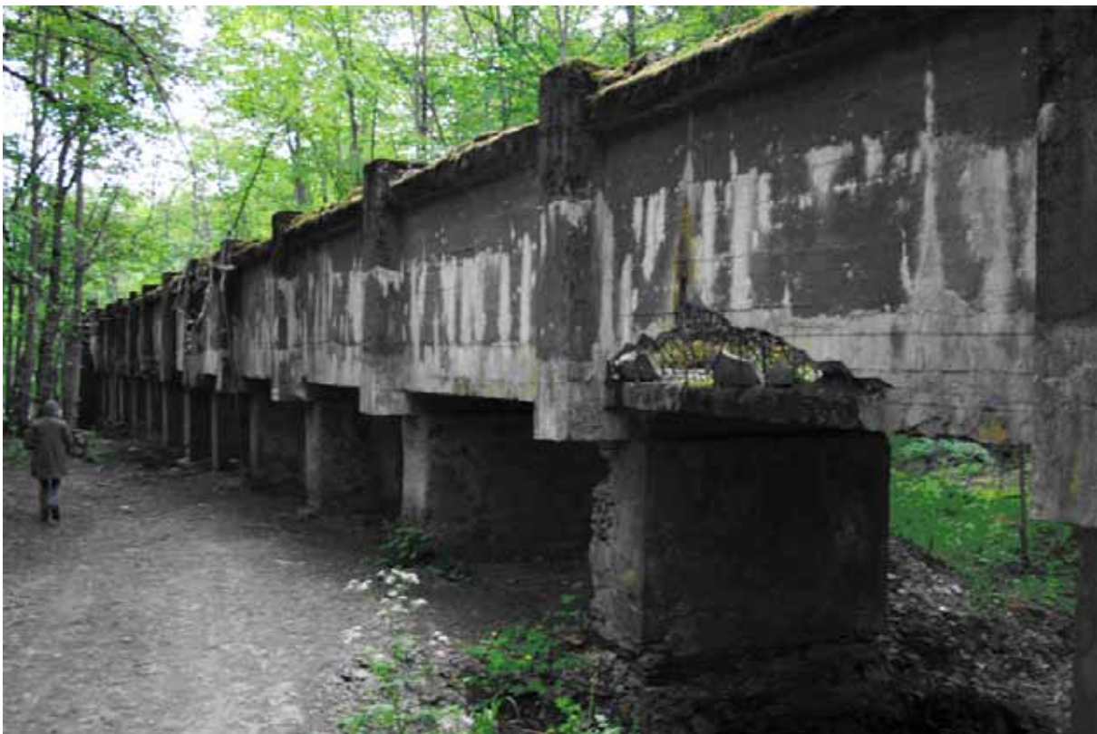
Foto 4. Nõmmeveski hüdrosoleme derivatsioonikanal (pildi autor Andre Zahharov)
