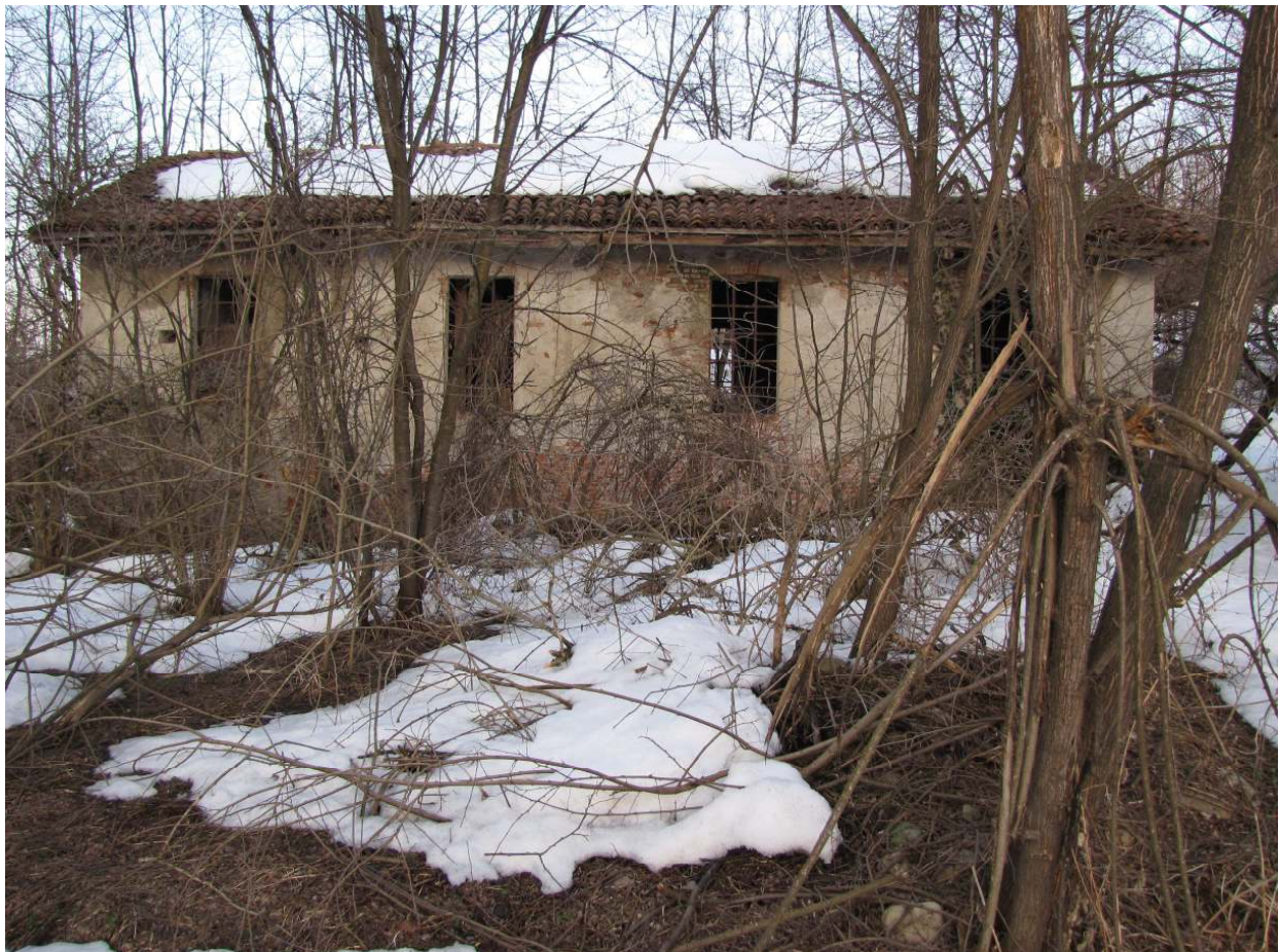
Figura 12: vista edificio mulino.
