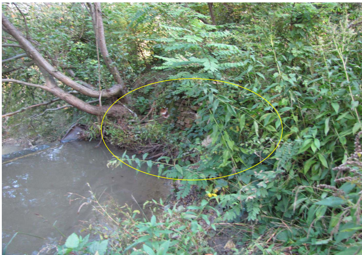
Figura 8: pareti di confine dell'alveo a monte briglia ancora esistenti.
