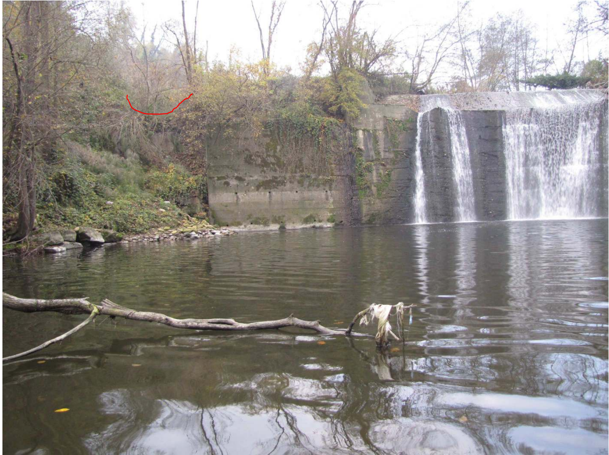
Figura 10: zona in cui si è verificato l'erosione spondale.
