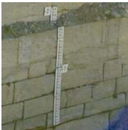
Figura 15: Esempio di installazione di asta idrometrica.
