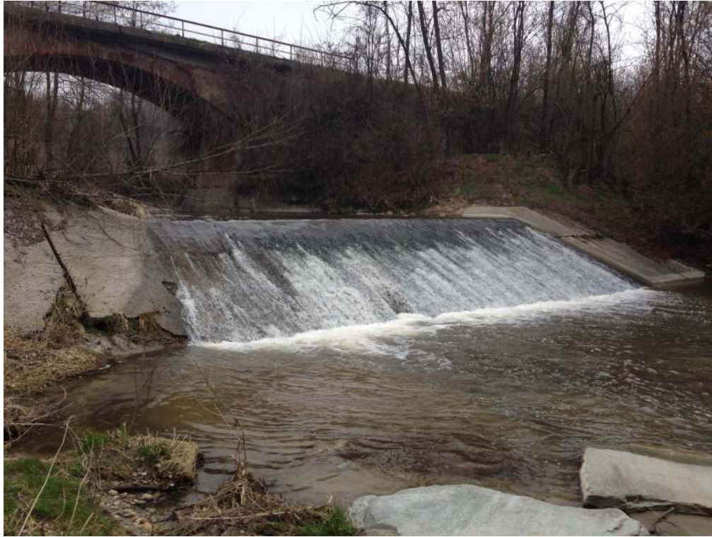
Figura 2: Traversa a valle dell'impianto in progetto; poco a monte della confluenza in Tanaro.
