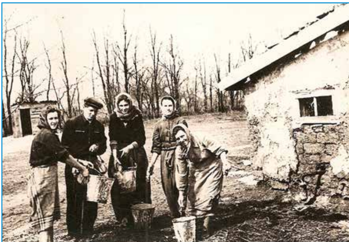
Пришла пора ремонта послевоенных хозпостроек!
