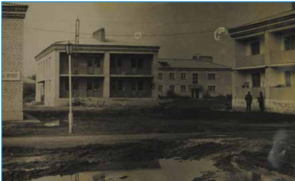
Строительство двухэтажных жилых домов
