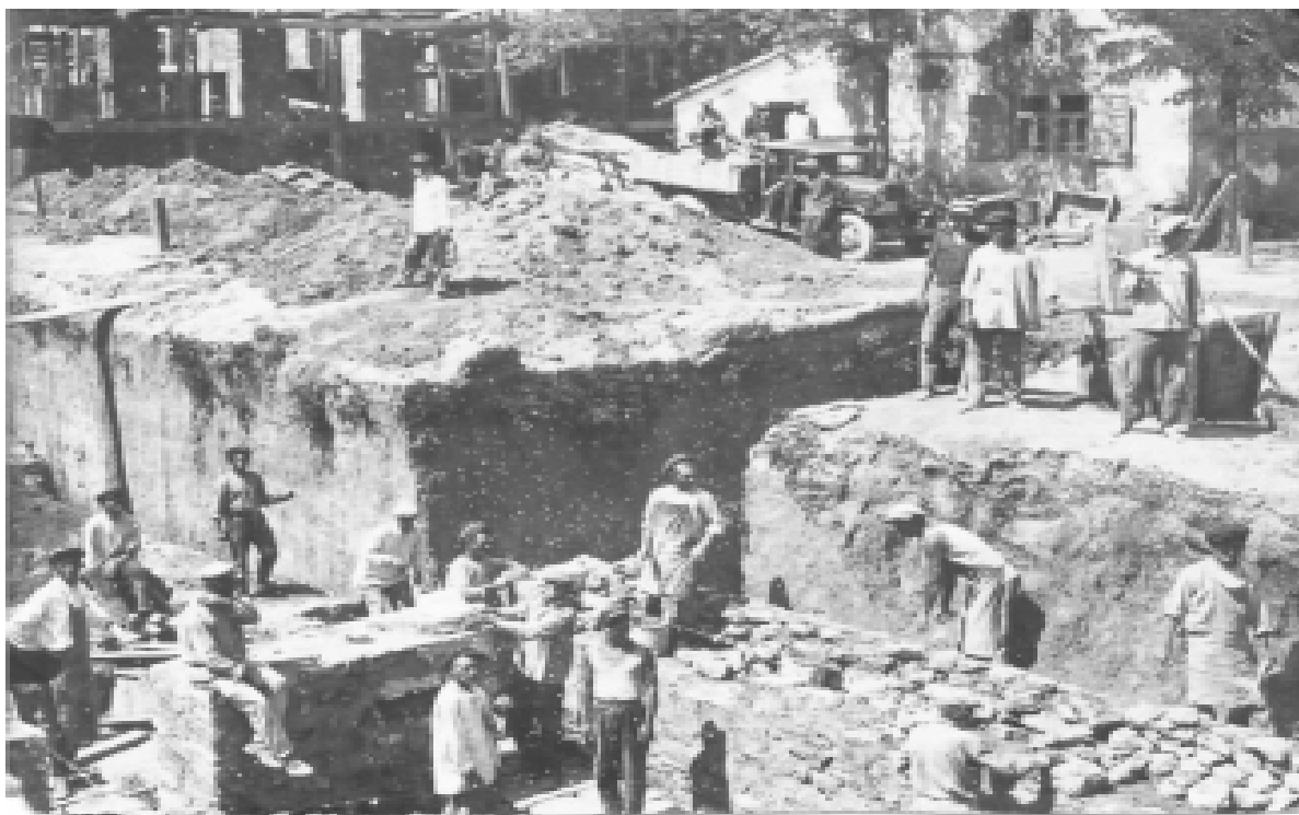
Тридцатые годы прошлого века. Закладка фундамента Дома культуры
