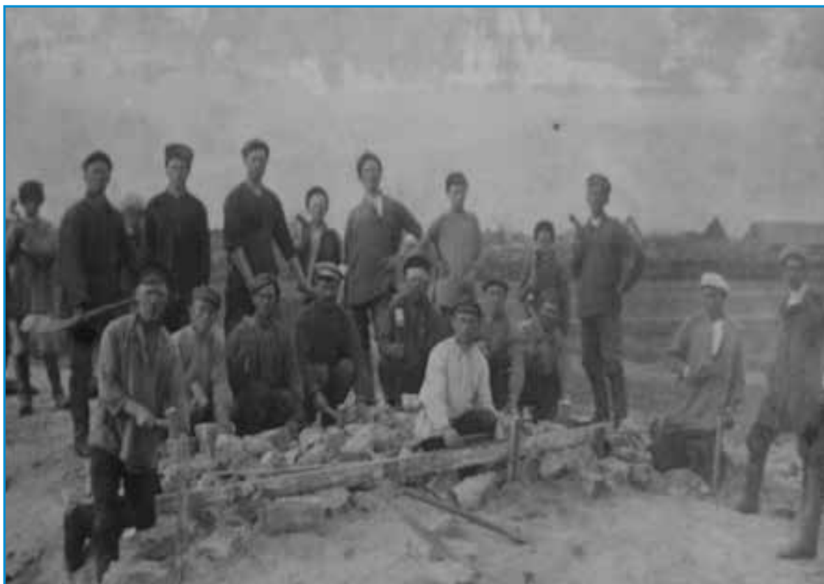
Вторая половина двадцатых годов. Строительство шоссейной дороги от центра с. Винодельного до железнодорожного вокзала. Крайний справа – А.И.Симкин
