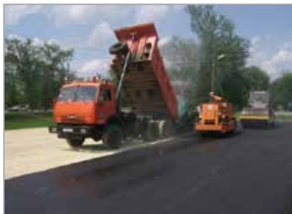
Идут дорожные работы
