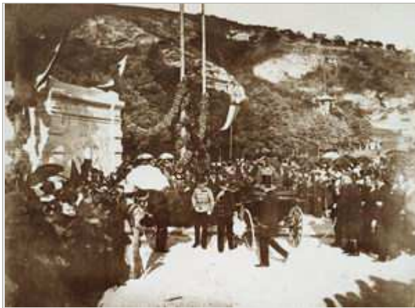
A Vízmű avatása a Tettyén 1892-ben.
