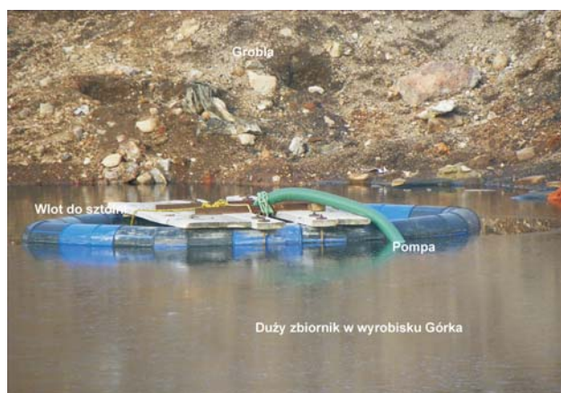
Fotografia 2.11. Odpompowywanie odcieków ze zbiornika dużego Źródło: fot. Ł. Lelek
