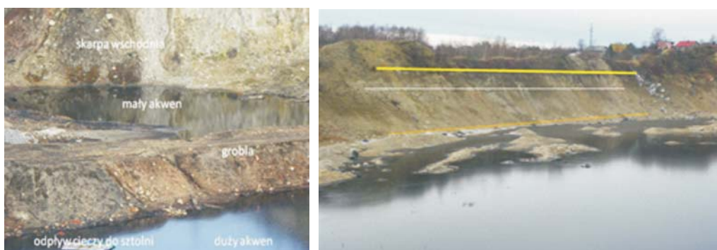
Fotografia 2.15. Widok fragmentów skarp wokół zbiorników i poziomów piętrzenia odcieków Źródło: opracowanie E. Pietrzyk-Sokulska; fot. A. Sobecka, październik 2011 r.
