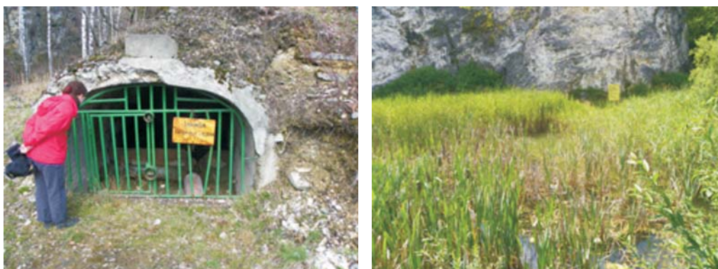
Fotografia 2.25. Sztolnia odprowadzająca odcieki ze zbiornika Górka i roślinność szuwarowa Źródło: fot. E. Pietrzyk-Sokulska
