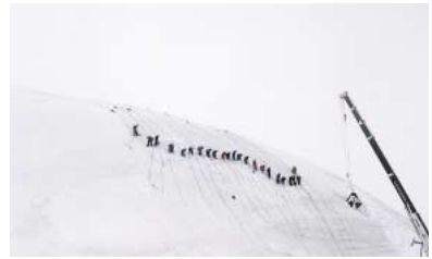
人力による法面の雪庇落とし
