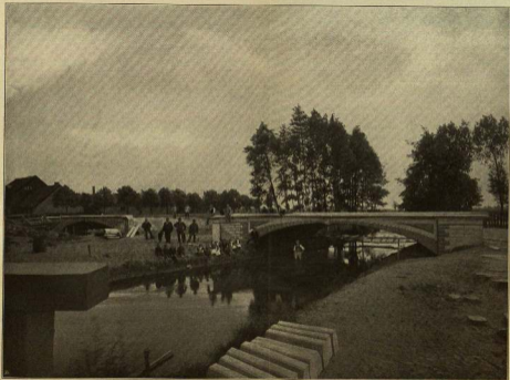
Chausseebrücken bei Wilsnack (ausgeführt 1902)
