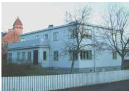
Stilren funkisvilla: enkel geometrisk grundform, ljus puts, platt tak och fönster över hörn. Skänninge Mjölbygatan-Murgatan.
