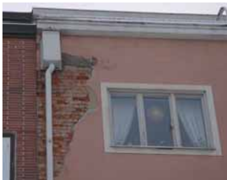
Funkishus i traditionell konstruktion med bärande yttervägg av tegel. Storgatan Linköping.
