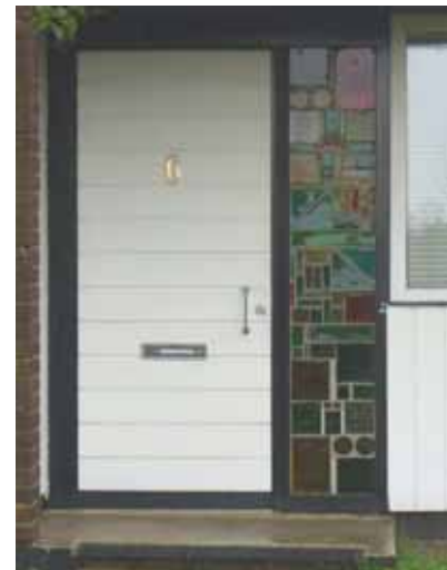
Entréer med sidoljus är vanliga på 1960-talet. Ytterdörren är också typisk för tegelvillor på 1970-talet.
