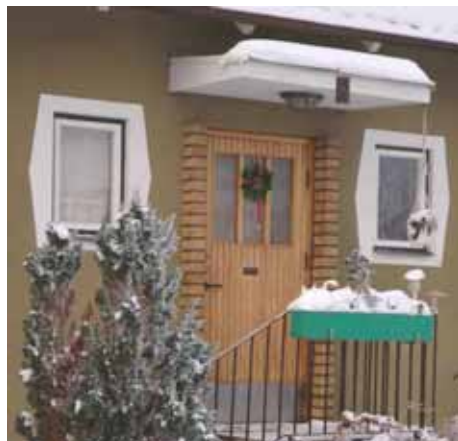
Vitputsade fönsteromfattningar är typiskt för 1950-talet. Kolonigatan Linköping
