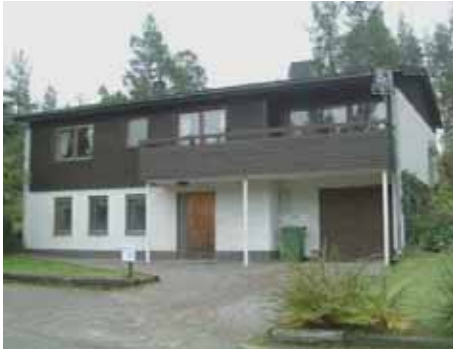
Balkongfronter och räcken var på 1970-talet vanligen av trä. Balkonger på villor med flacka tak bars ofta upp av pelare. Majeldsvägen, Valdemarsvik
