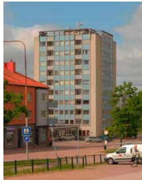
"Kannan" vid Stångebro i Linköping byggdes 1956-57 och har drag av både "international style" (curtain-wall fasader) och "brutalism" (betongstommen är del av fasadens uttryck). Foto: Lars Ekelund
