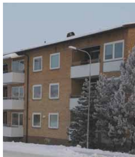
Från och med 1950-talet blir balkonger som är indragna från fasadlivet vanliga. Gärdes-gatan, Linköping
