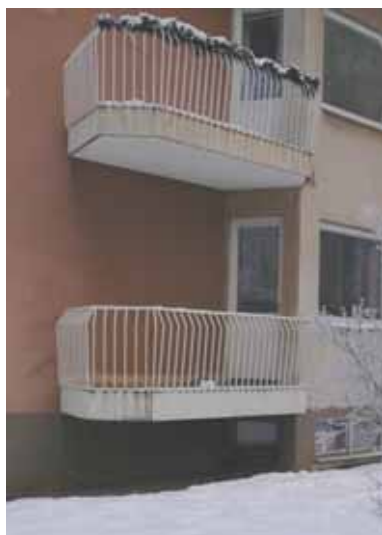
Smäckra balkongfronter av smide är vid sidan av plåtfroter vanligast under 1930-1950-talen. Kinda-gatan, Linköping
