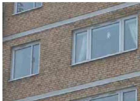
Vanlig fönsterindelning på 1960-talet. Hamngatan, Linköping
