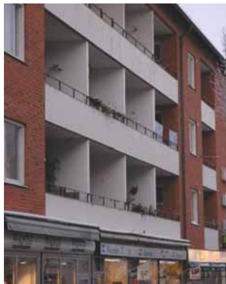
Från och med 1950-talet blir balkonger som är indragna från fasadlivet vanliga. Gärdes-gatan, Linköping
