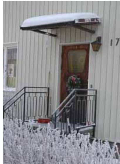
Entré med välbevarad 1950-talskaraktär: skärmtak och ytterdörr av fernissat trä. Kolonigatan, Linköping
