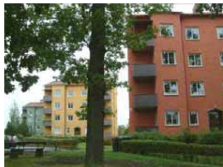
Punkthus från 1952-54. Lasarettsvägen Högby, Finspång.
