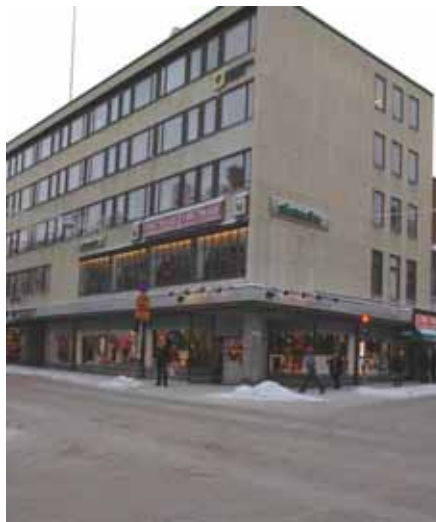
Fasadskivor av sten och fönsterband. Kontors- och affärsbyggnad med 1960-talskaraktär i korsningen Storgatan - St Larsgatan i Linköping.
