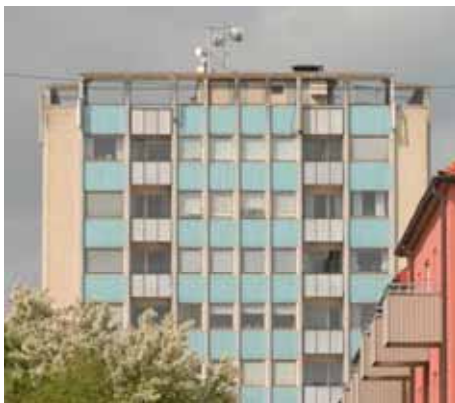
"Kannan" vid Stångebro i Linköping byggt 1956-57 representerar den moderna byggtekniken med bärande mellanväggar och bjälklag av armerad betong, samt ytterväggar utan bärande funktion.
