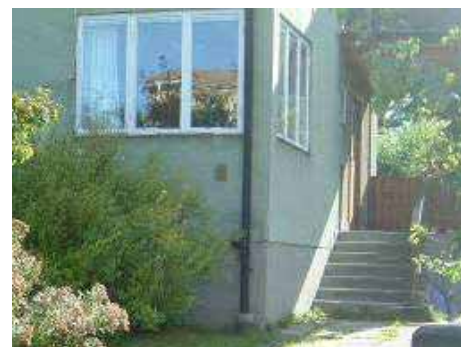
Fönster i hörn är ett av funktisarkitekturens kännetecken, och skulle ursprungligen signalera en modern byggteknik (med ytterväggar som inte är bärande). Stora Allén, Finspång
