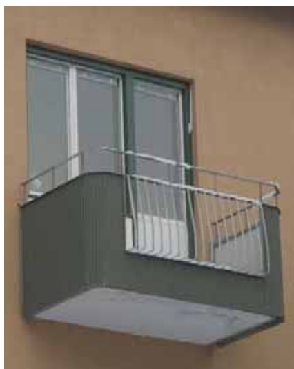
Under 1940-1950-talet består balkongfronterna ofta av en kombination av smide och plåt. Syrén-gatan, Linköping
