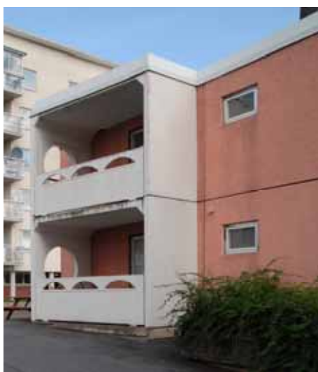
Miljonprogramshus med prefabricerade fasadelement av sandwichtyp, ytan består av frilagd ballast (sjösten), som senare målats rosa. Foto Lars Ekelund
