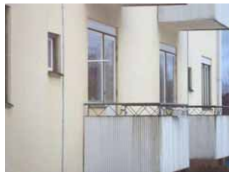
Ljusa slätputsade funkifasader, även balkongfronterna i finveckad sinus-korrugerad plåt är typiska för 1930-talet. Rydsnäs, Ydre
