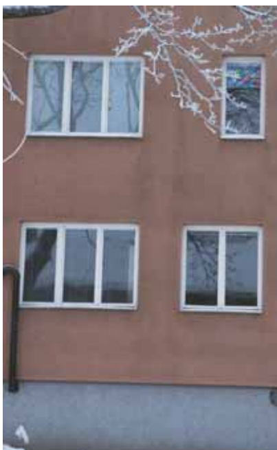
1930-talets vanligaste fönster: två- eller trelufts-fönster, smala enlufts-fönster i badrum och liknande. Syréngatan, Linköping
