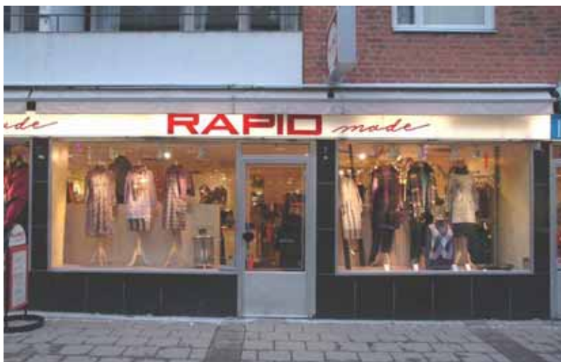
Butiksentréer och skyltfönster från 1930-talet och in på 1960-talet är vanligen kantade av blanka profiler av rostfritt stål. Exemplet på bilden från Nygatan i Linköping har ett tidstypiskt utseende, men är av aluminium, ett material som blir mer vanligt under 1970-talet.
