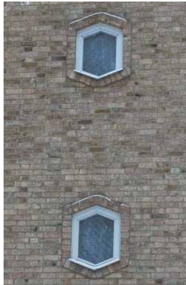
Tidstypiska sexkantiga fönster Ulvåsavägen, Linköping
