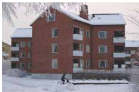
Stjärnhus, kvarteret Observatorn, Fridhem - Gottfridsberg, Linköping.
