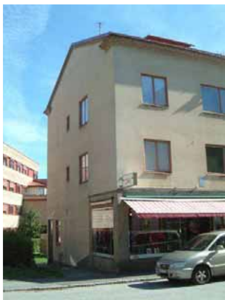
Byggnad från 1947 i nyrealismens anda, påminner om 1920-talsklassicismen med t ex karakteristiskt markerad takföt. Jonas Wenströms väg, Finspång
