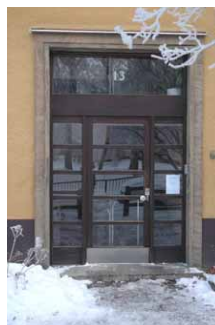
Vackert exempel på entré med välbevarad 1930-talskaraktär: portar av fernissat trä med stora glasparter. Brunnsgatan, Linköping
