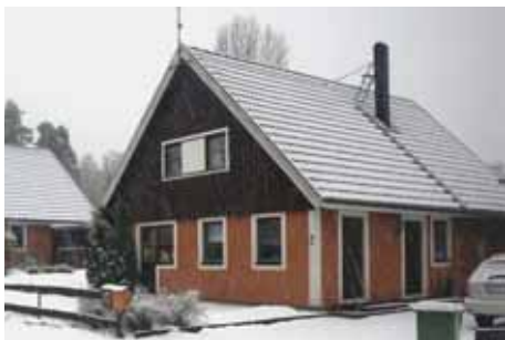
Trähus från senare delen av 1970-talet med brant sadeltak och betongpannor. Kornvägen Strålsnäs.
