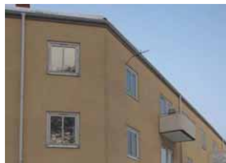
Tak enligt funktionalismens ideal: osynligt från marken och knappt synlig takfot. Västanågatan-Oxgränd Linköping.
