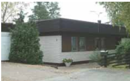
Villa från 1973: platt utskjutande tak med kraftig sarg av träpanel var vanligt i början av 1970-talet. Kopparvägen Valdemarsvik.
