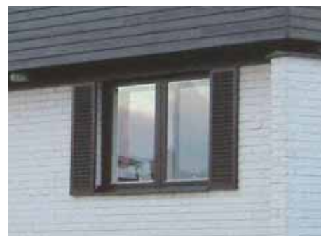
Fasta fönsterluckor som dekoration och mörklaserade fönster är karaktäristiska för 1970-talet. Lostigen, Söderköping
