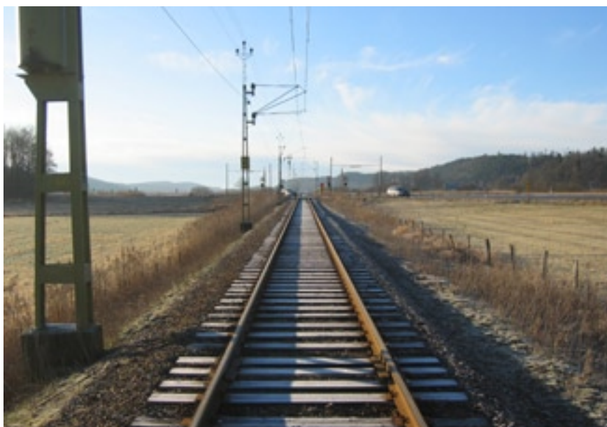
Viskadalsbanan med skarvspår och träslipers.
