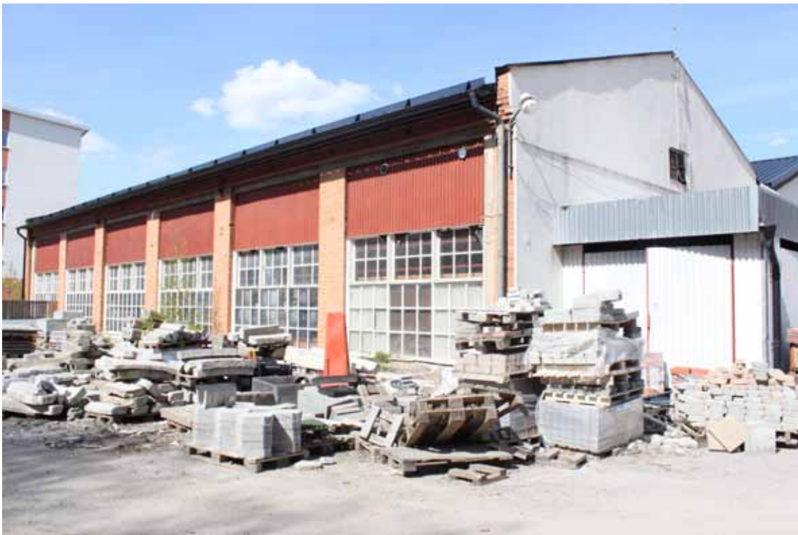
Del av byggnad C som föreslås rivas.
