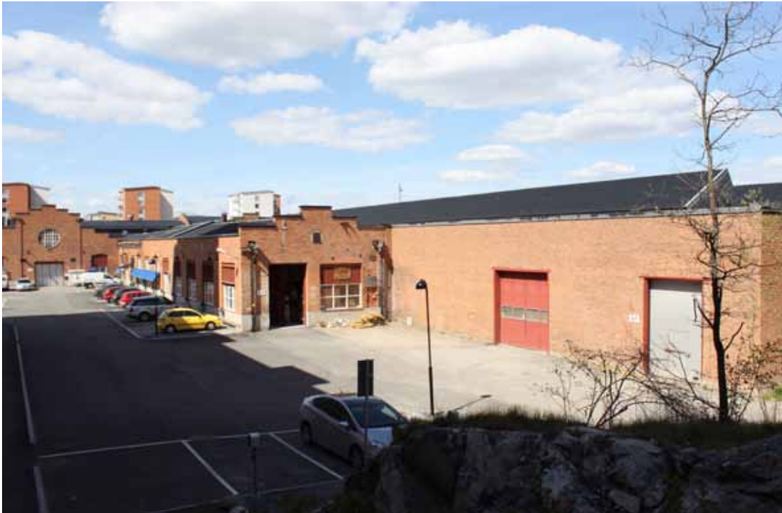
Byggnadsdelarna till höger bild, byggnad A, föreslås rivas för att ersättas av ny bostadsbebyggelse.
