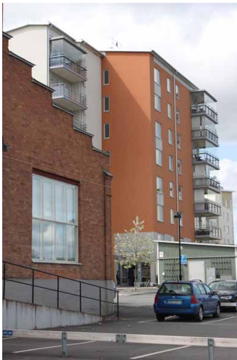
Byggnad B i mötet med "Kajenområdet".
