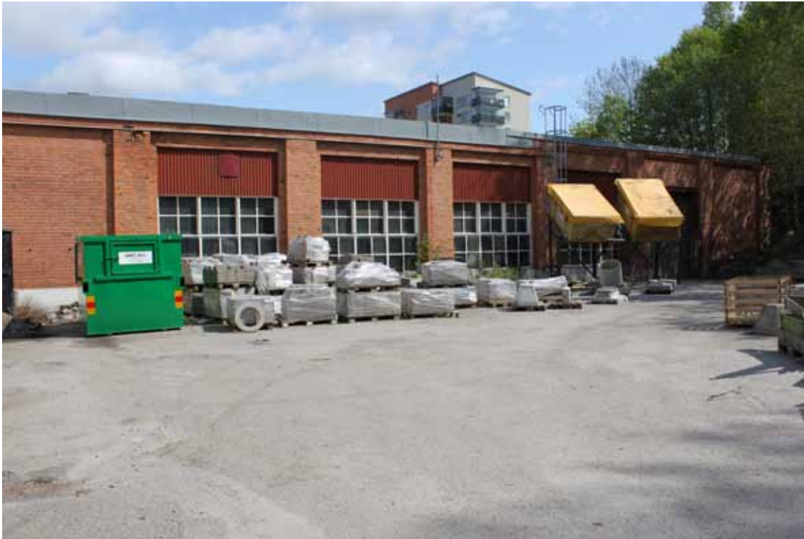
Del av byggnad C som föreslås rivas.
