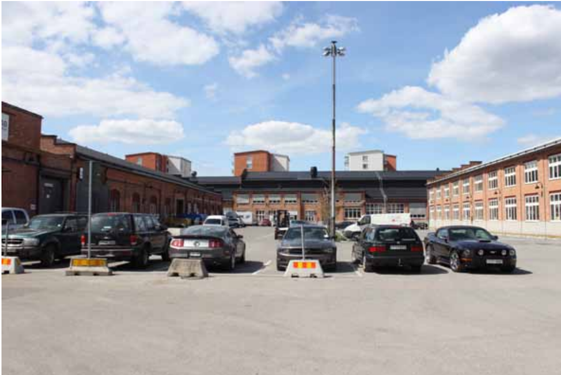
Miljöskapande platsbildning mellan byggnaden A, B och K.
