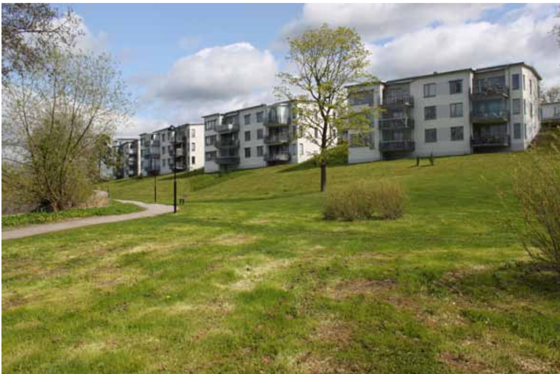
Området "Berget" intill Kallhälls gård.
