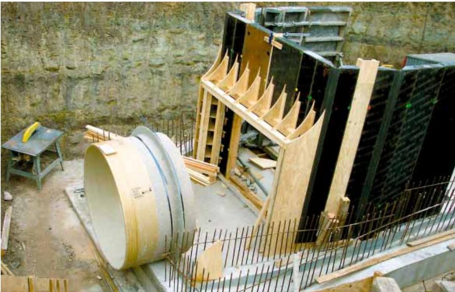
Anschlussstutzen des Flowtite-Systems vor dem Einbetonieren in das Zulaufbauwerk des Kraftwerks.
