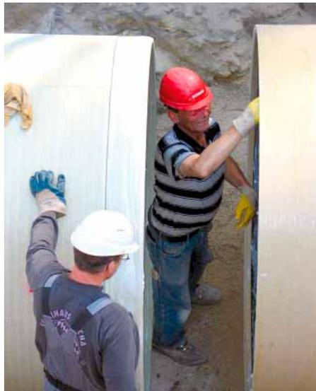
Vorbereitung der Flowtite-Kupplung für die Aufnahme des nächsten Rohrs (links).
