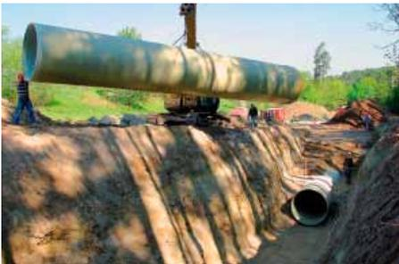
Die 12 Meter langen GFK-Wickelrohre DN 1800 waren jeweils binnen 30 Minuten verlegt und angekoppelt.
