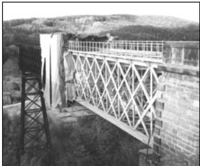
Natírání části starého viaduktu - listopad 2001
