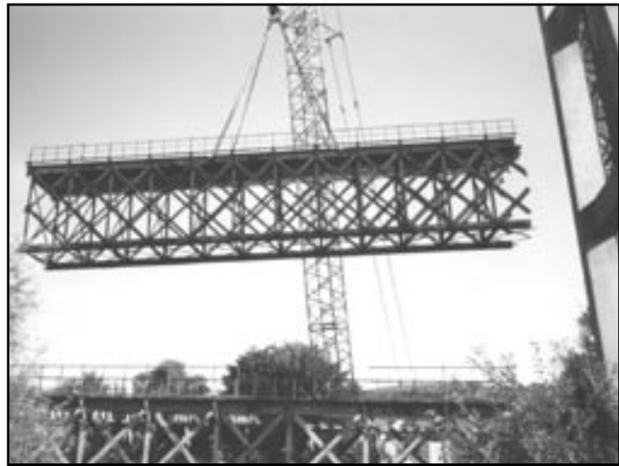
Demolice viaduktu - 5. září 1999
