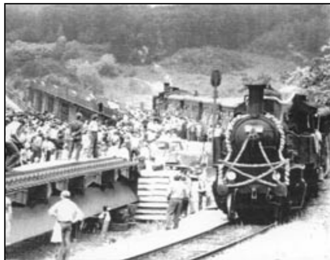
Rozloučení se starým viaduktem - 10. června 1978
