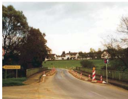
Fahrbahneinengung auf der Nimsbrücke.
