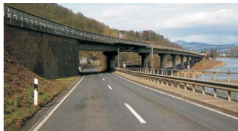
Unkelsteinbrücke: Erneuerung nach längerer Restnutzungsdauer (wirtschaftliche Erhaltungsstrategie).
