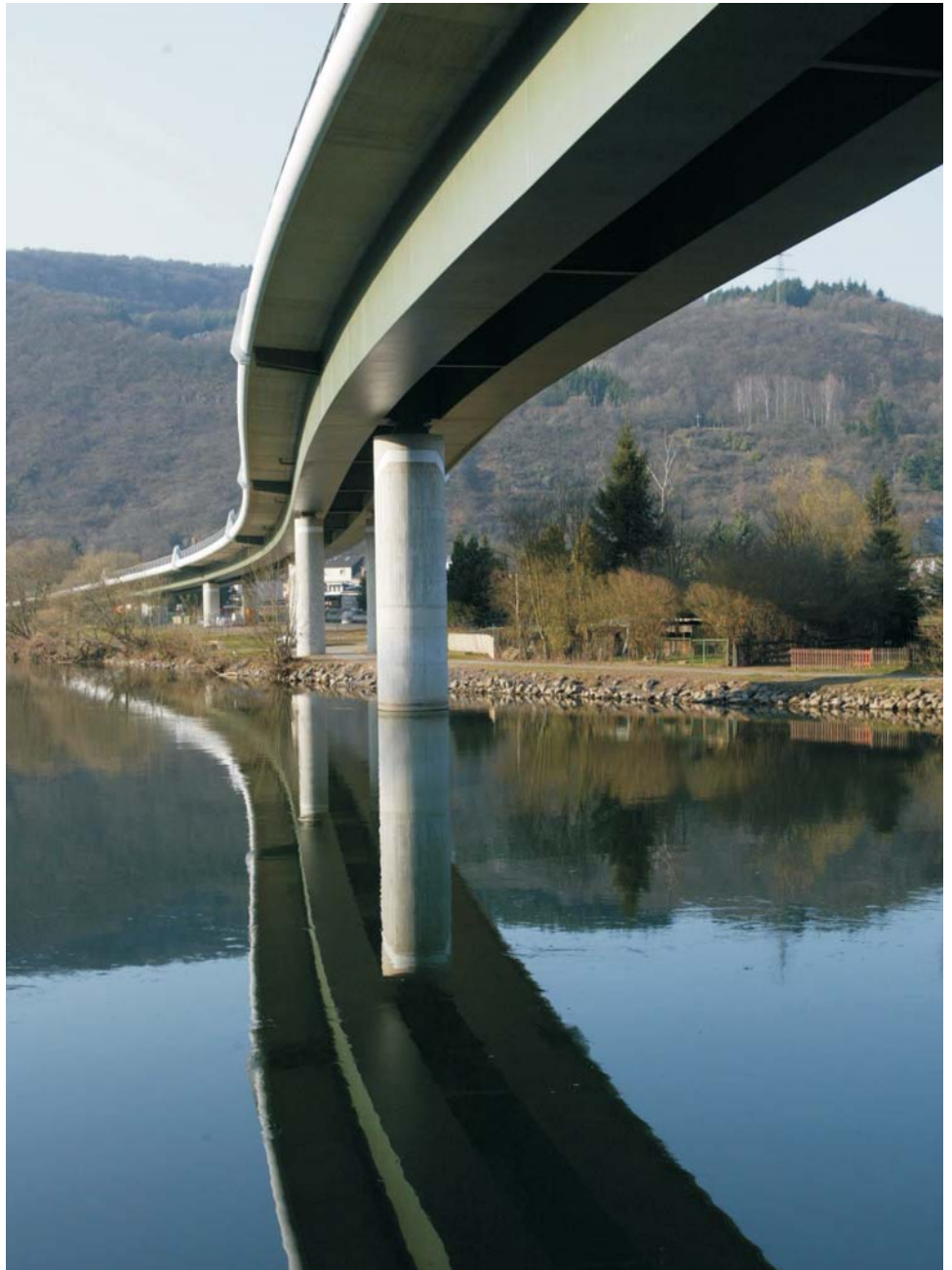
Flußbrücke bei Fachbach.
