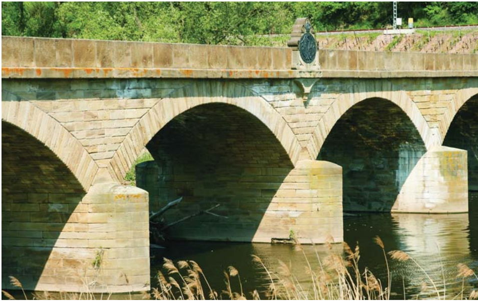
Luitpoldbrücke bei Oberhausen an der Nahe (Baujahr 1889) - so wird heute keine Brücke mehr gebaut.
