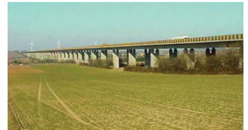
Pfeddersheimer Brücke: Verstärkung des Hohlkastens
