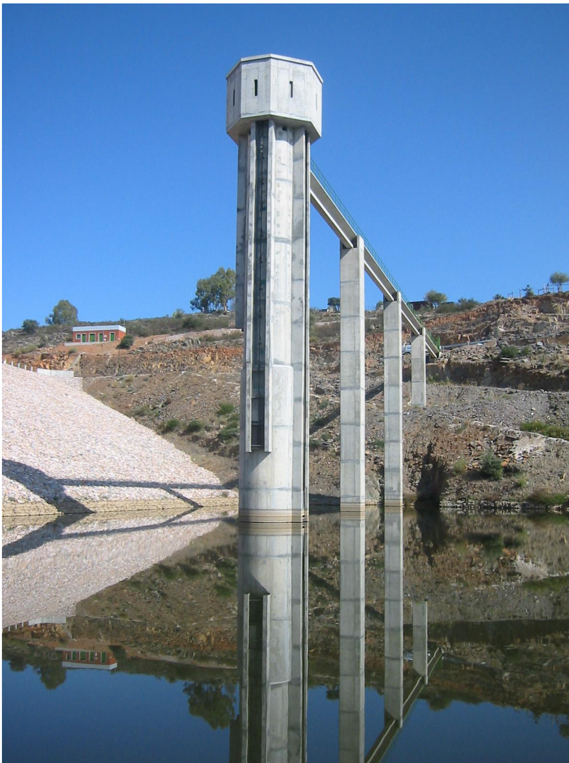
TOMADA DE ÁGUA
