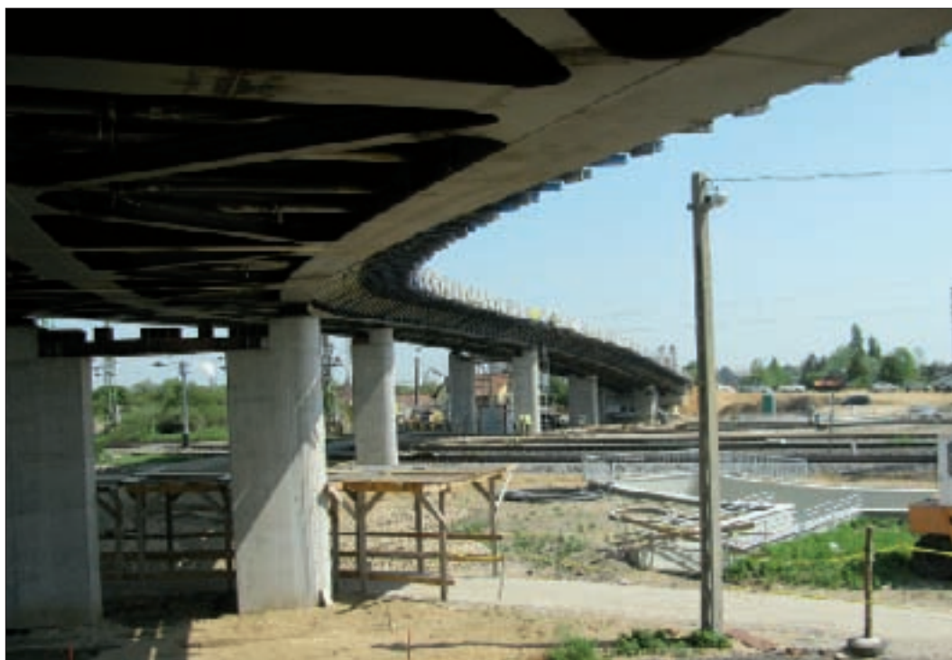
23. kép: A felszerkezet teljesen becsaluzva
