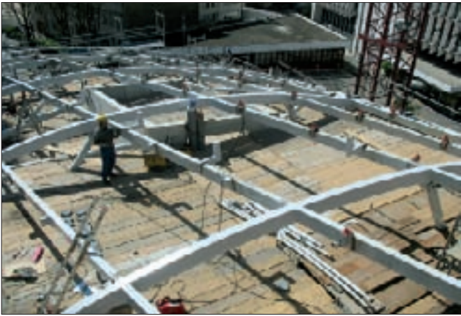
38. kép: A homlokzattartó torz felületű szerkezeti részek üzemi előszerelése
