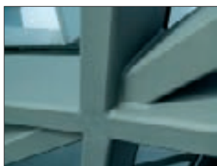
18. kép: A kettős kúp homlokzatát tartó rácsos szerkezetet eredetileg csőből tervezték, de a kivitelezők nyomására átalakították a sokkal egyszerűbben illeszthető, téglalap keresztmetszetű, üreges szelvényekre
