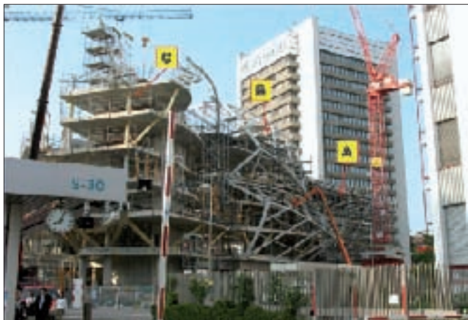
36. kép: Kezdődik a vasbeton építményre rögzített (35 féle) homlokzattartó, térben kétszeresen görbült panelem szerelése
