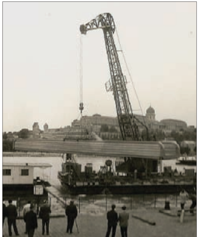
11. ábra: A kikötőhíd beemelése
