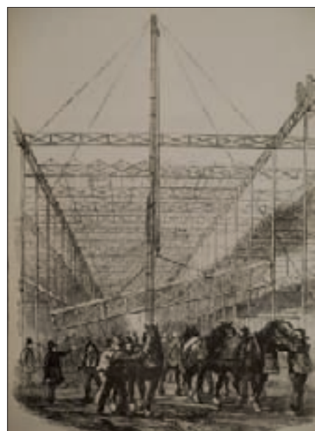
2. kép: A palota tipizált szerkezeti egységeinek akkor forradalmian korszerű technológiával, bámulatos ütemben történő szerelése
