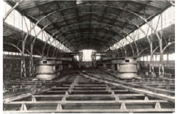
7. kép: Az Erzsébet lánchíd kapuzati oszlopainak előszerelése a 150 m hosszú, 30 m széles, két 17 m széles oldalhajóval is rendelkező csarnokban
