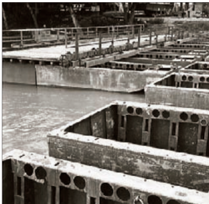
1. ábra: A Tiszán felépített alumínium pontonhíd részlete
