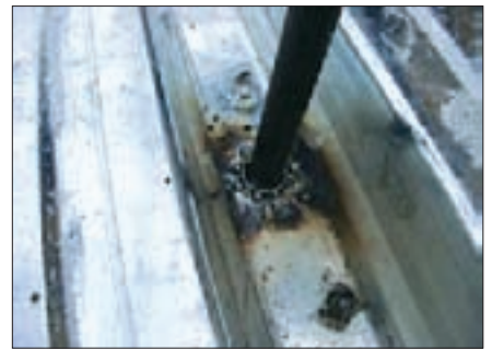
A helyszíni KÖCO támogatás eredménye a tökéletes csaphegesztés
