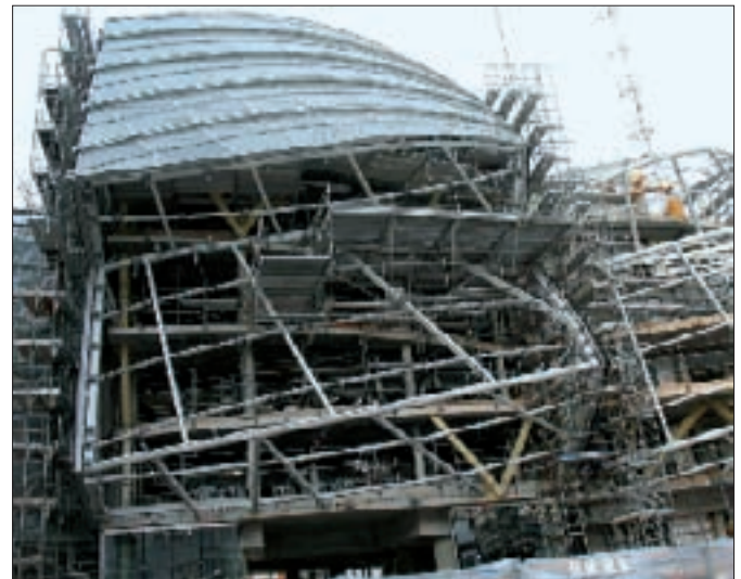
43. kép: A kép a részben már készre szerelt homlokzati paneleket és az azokat rögzítő rácsos szerkezetet szemlélteti
