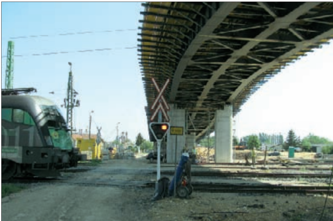
2. kép: Építési állapotban üzemelő szintbeli átjáró már az épülő új felüljáróval
