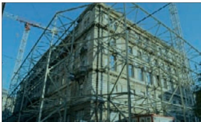
2. ábra: Az Eiffel Palace műemléki téglahomlokzatának ideiglenes acélszerkezetű megtámasztó állványzata. Statikus tervező: Schnierer Gábor CEOS Kft., Pohl Ákos CEOS Kft.
