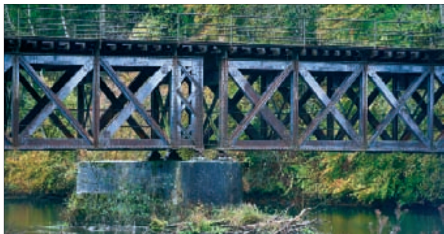
1. kép: Az 1890-ben épült dietfurthi vasúti Duna-híd jellegzetes részlete
