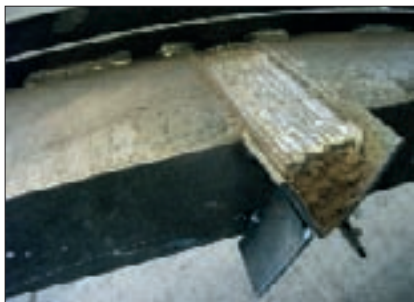
24. ábra: Egy kézre hegesztett toldóvarrat
