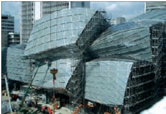
37. kép: A homlokzatépítés befejezéshez közeledik
