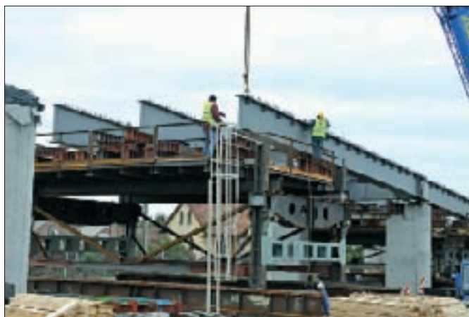
16. kép: Szerelési segédjárom
