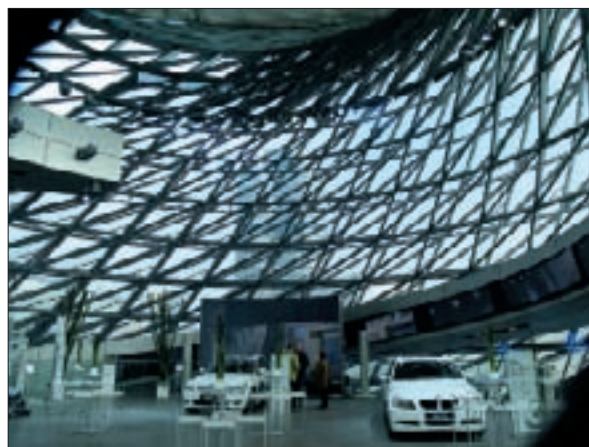
19. kép: A kettős kúp belülről (a homlokzati elemeket rögzítő rácszat zavaróan hat)
