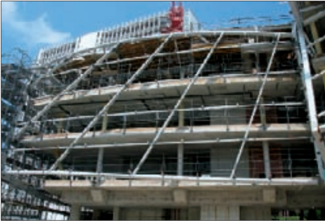
39. kép: A tartószerkezet helyszíni szerelése
