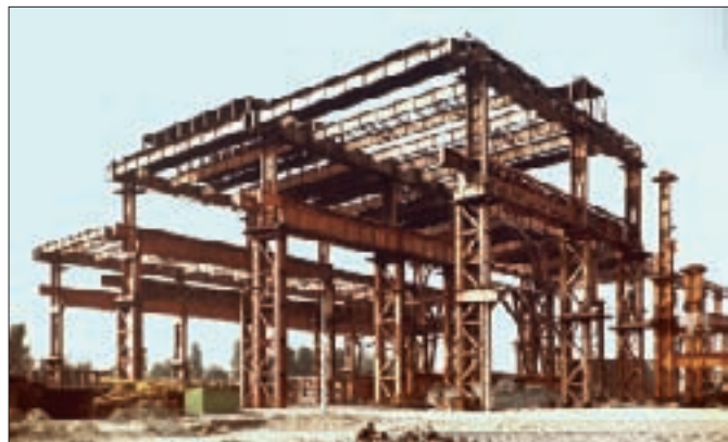
11. kép: A Dunai Vasmű Konverteres Acélműve ún. alacsony csarnokának szerelése (1980)
