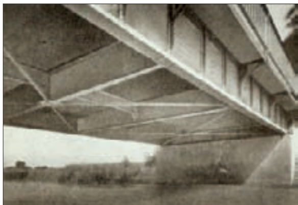
2. ábra: A szabadszállási alumíniumhíd – alulnézet
