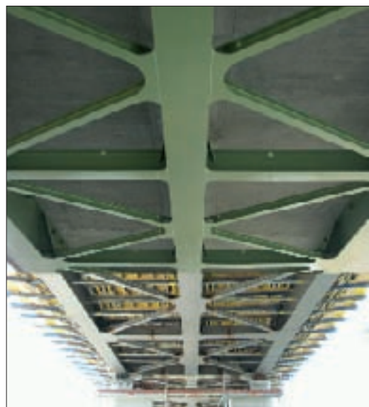
9. kép: Hídszerkezet alulnézetei építés közben és elkészülve
