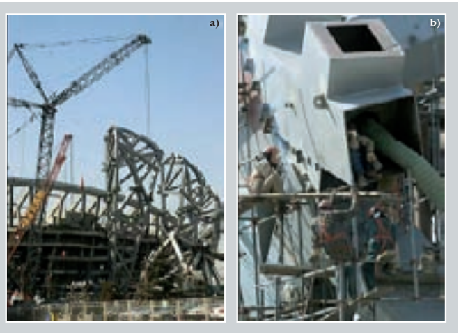
22. kép: a) A csarnok acélvázának szerelését egyidejűleg több helyen végezték b) A szerkezet minden illesztése hegesztett (1000 hegesztő 10 hónapon át tartó, háromműszakos munkájára volt szükség)
