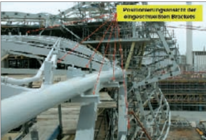
40. kép: Az üvegpnelek rögzítése a tartószerkezetre hegesztett konzolokon (Brackets) lévő gömbfejek révén történik
