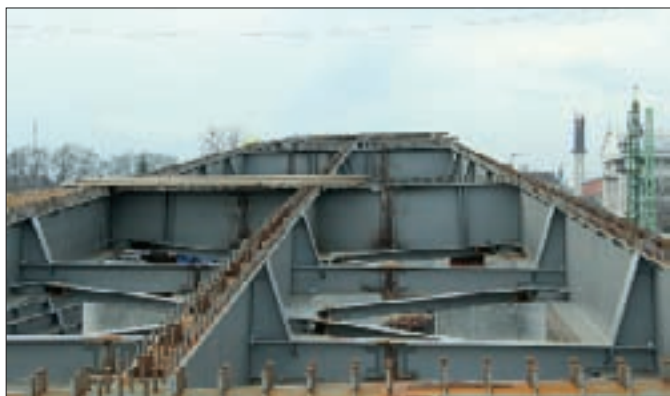
15. kép: Főtartó felső övek és támasz-keresztartó felső övek, illetve az alsó szélrács és csomópontja a helyszíni szerelésen
