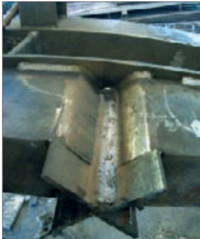
23. ábra: A szegmensek toldása kifutólemezek alkalmazásával
