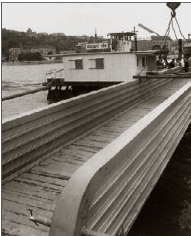
7. ábra: Alumínium kikötőhíd beépítése
