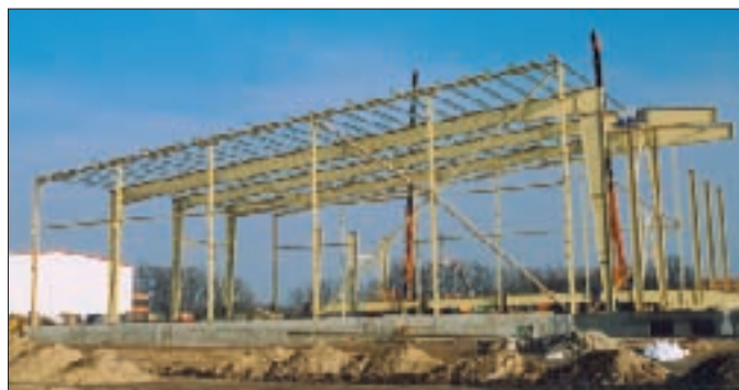
12. kép: Egy könnyűszerkezetes raktárház korszerű acélvázának szerelése (2002, Rutin Kft.)
