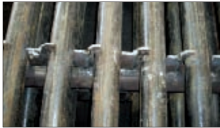
6. kép: Egy összeszerelt egység: alátámasztó csövek keresztirányú csövekkel kiegészítve (fűtőfelület), amelyen keresztül áramlik a gőz, a villamos energia előállításához
