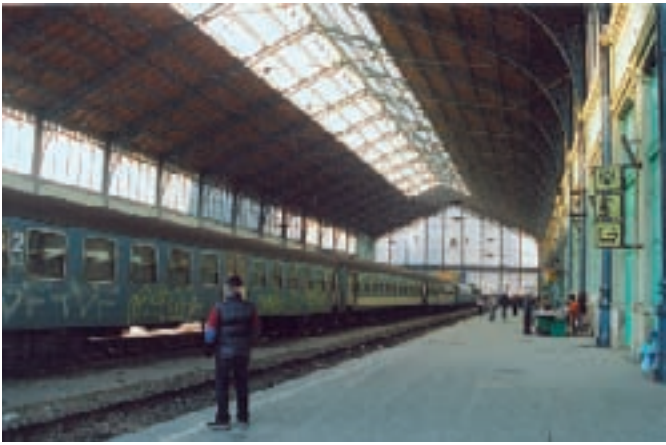
5. kép: A pályaudvar vonórudas keretként kialakított, filigrán, acélvázás tetőszerkezete
