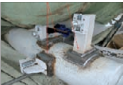
← 41. kép: A kép a helyszínen felhegesztett három konzolt szemléltet (összesen 1533 darab van)
