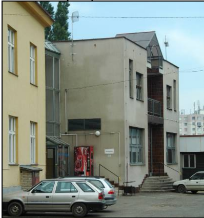
Turek, Matyáš: STŘEDNÍ ZEMĚDĚLSKÁ ŠKOLA – POSTMODERNÍ DOSTAVBA JÍDELNY, Mendelova ulice, P 1984, 25 S 2. pol. 80. let 20. století, ■ 49°47'07,6" 14°40'55,1"
