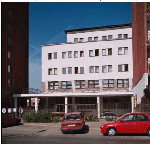
Lampa, Radek: DŮM SLUŽEB BENEŠOV (Bemoinvest), Poštovní náměstí / F. V. Mareše 7/2056, 1989 – 92, 49°46'52,8" 14°41'24,9"
