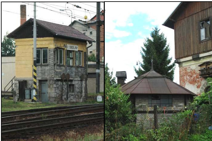
nezjištěný autor: TECHNICKÉ ZÁZEMÍ NÁDRAŽÍ – VÝTOPNA (č.p. 395), VODÁRNA, STAVĚDLO, S konec. 19. stol., ■ 49°46'49,4" 14°40'57,1"
