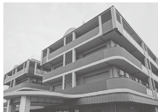
新築の東大阪養護老人ホーム
