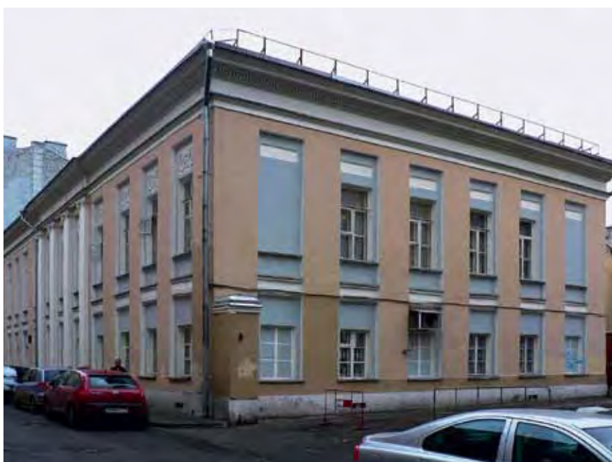
Вид на боковой фасад дома после реставрации
