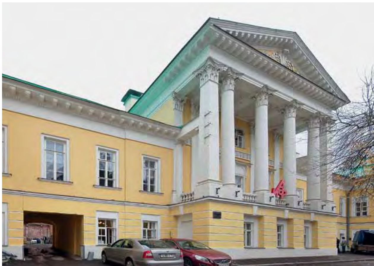
Фрагмент фасада дома с портиком после реставрации
