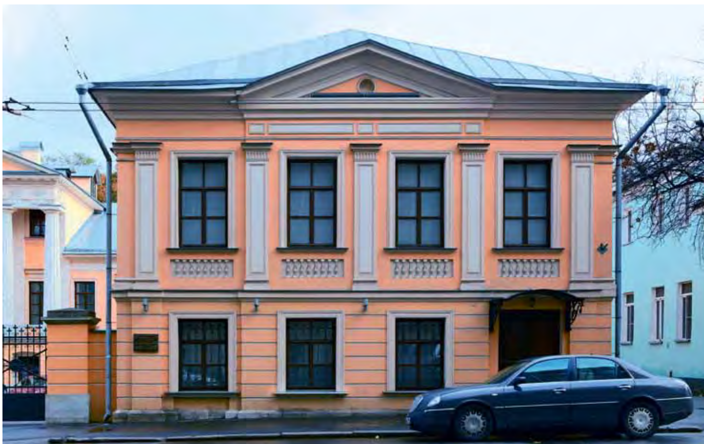
Фасад бокового флигеля дома после реставрации
