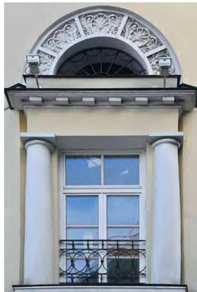
Фрагмент колокольни церкви после реставрации
