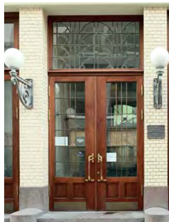
Центральный вход в Торговый дом после реставрации
