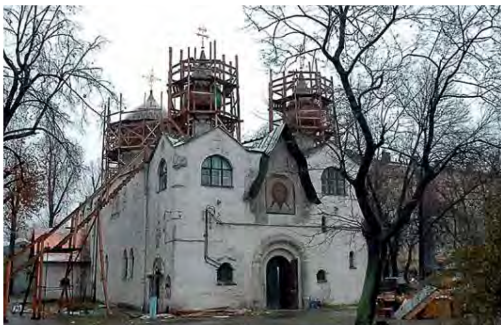
Покровский собор Марфо-Мариинской обители в процессе реставрации
