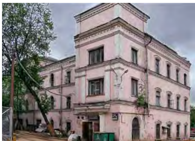
Западный фасад храма до реставрации. 2008 г.
