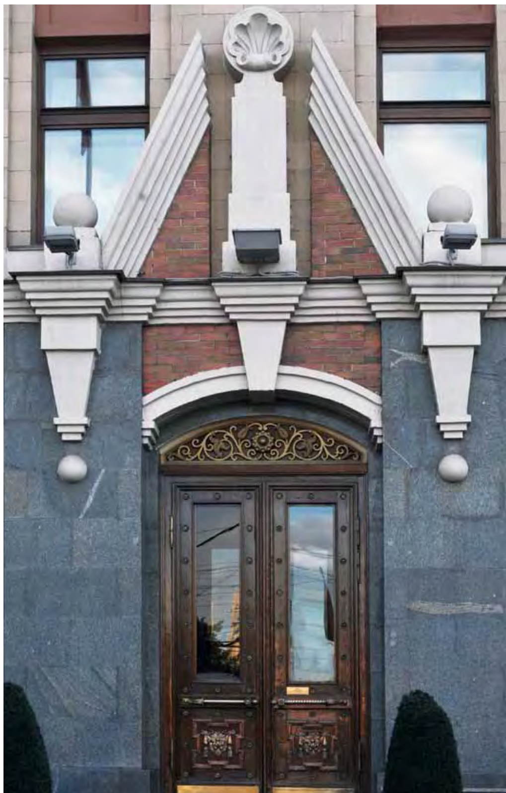
Один из входов в гостиницу после реставрации
