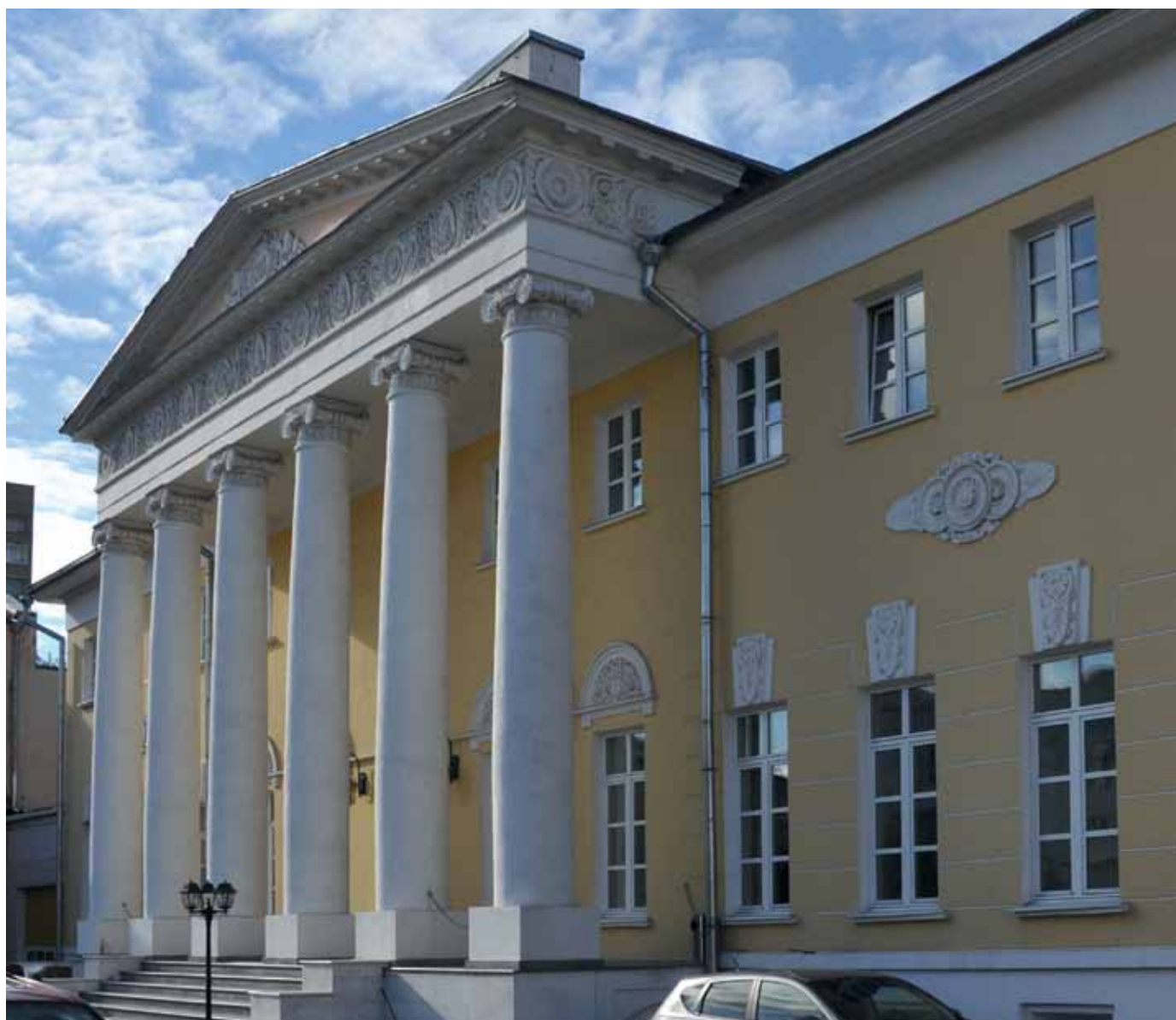
Вид на главный фасад усадьбы после реставрации
