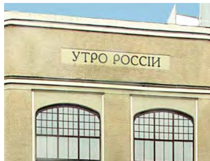
Фрагмент фасада типографии с окнами после реставрации
