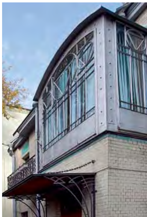
Фрагмент бокового фасада особняка до и после реставрации
