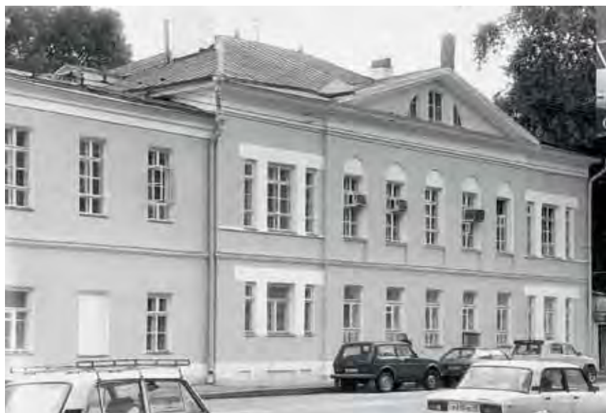
Вид на уличный фасад дома И. И. Барышникова до и после реставрации
