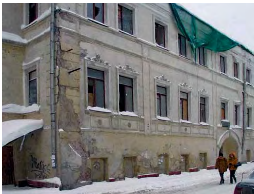
Вид на главный фасад дома до реставрации. 2003 г.
