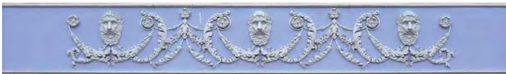
Лепной декор фасада усадьбы после реставрации
