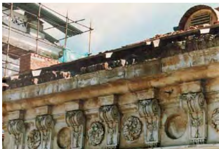
Дом П. Е. Пашкова в процессе реставрации
