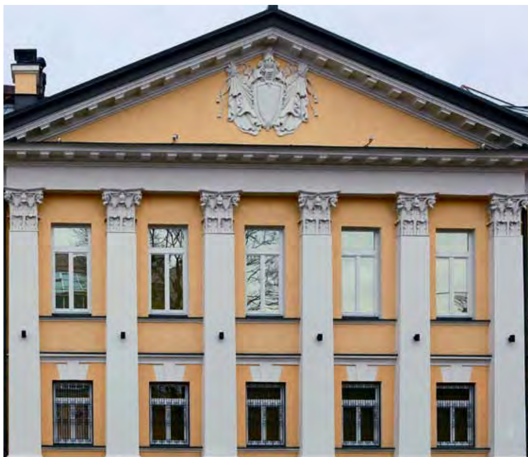
Главный фасад особняка после реставрации
