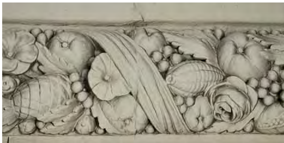
Элементы лепного и чугунного декора гостиницы после реставрации
