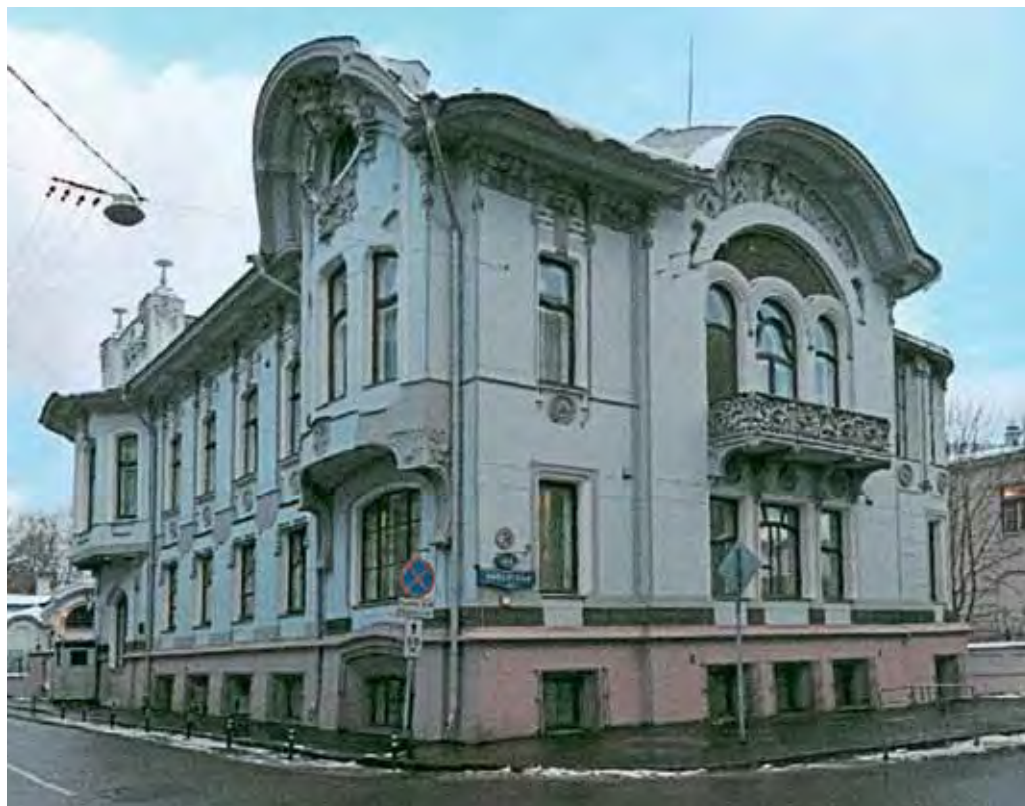
Особняк до реставрации. 1990-е гг.
