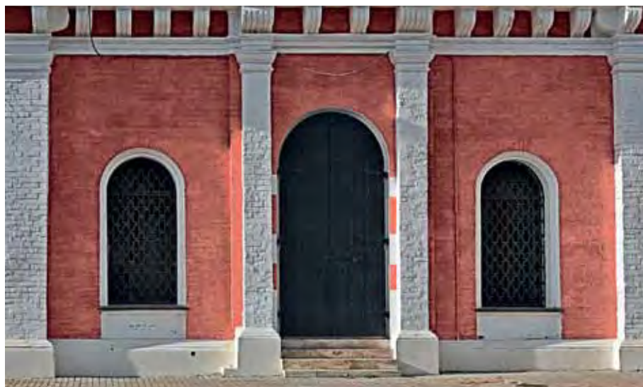
Вход в нижний храм после реставрации
