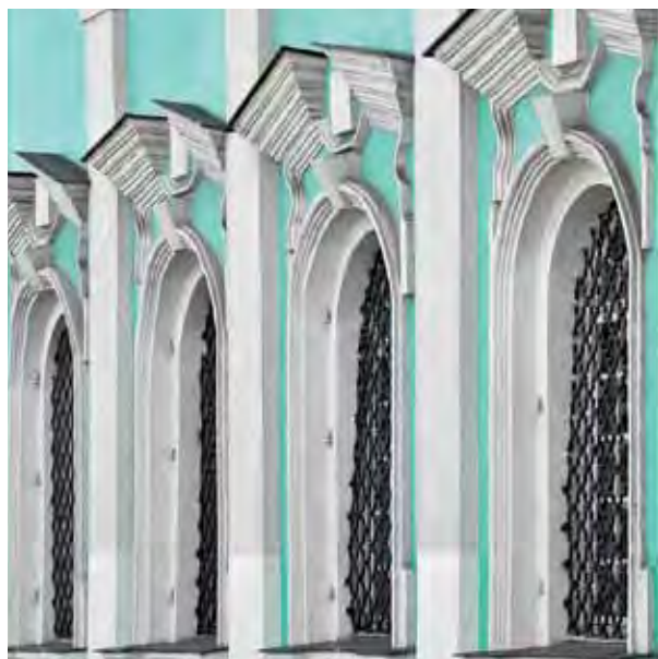
Окна храма после реставрации
