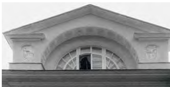
Фрагменты крыши и фасада дома до реставрации
