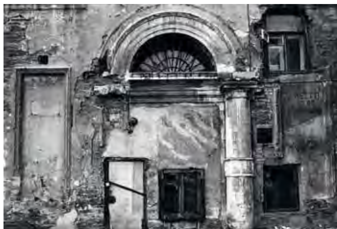
Церковь до реставрации. 1977–1979 гг. Вид с юга
