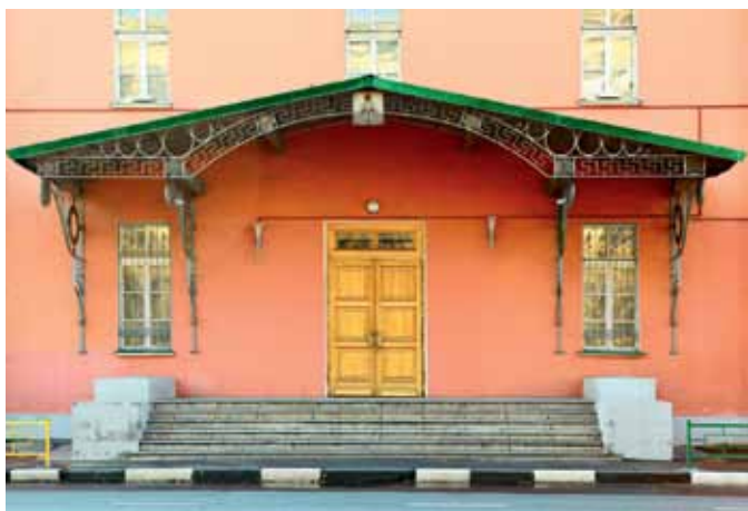
Вид на один из входов в корпус с козырьком после реставрации
