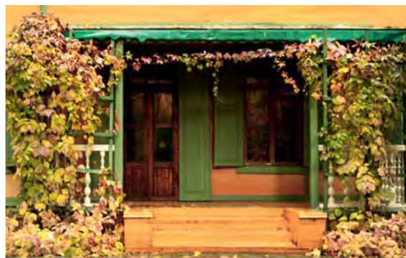
Парадное крыльцо дома-усадьбы после реставрации
