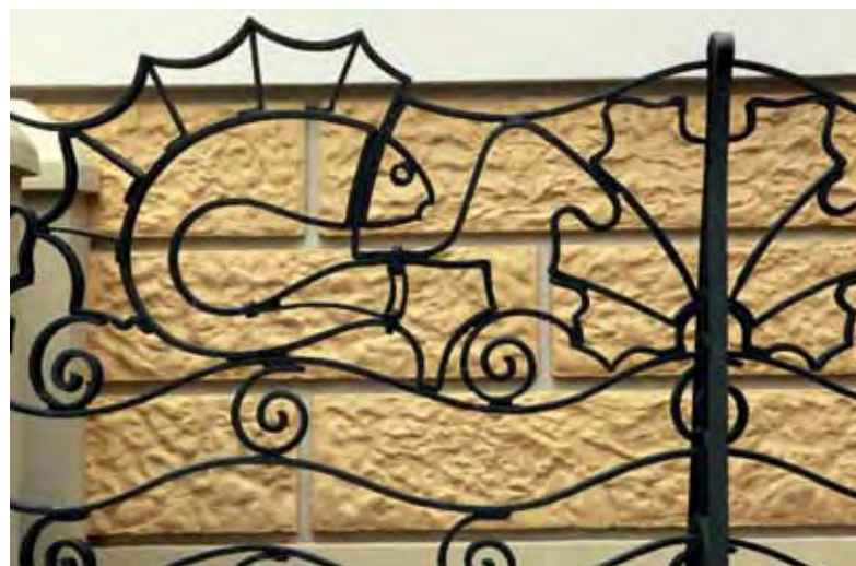
Фрагмент ограды после реставрации
