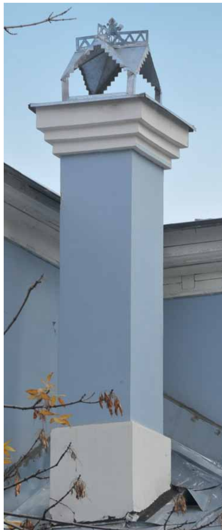
Печная труба с декоративным завершением на крыше дома
