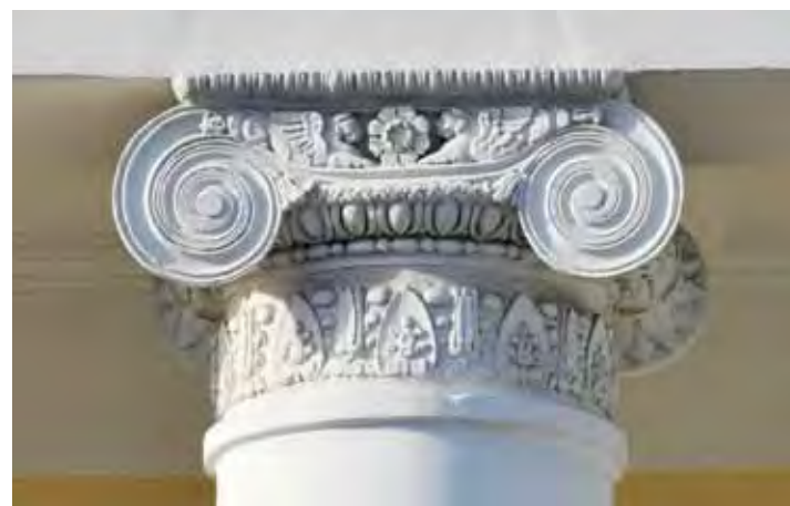
Капитель колонны после реставрации
