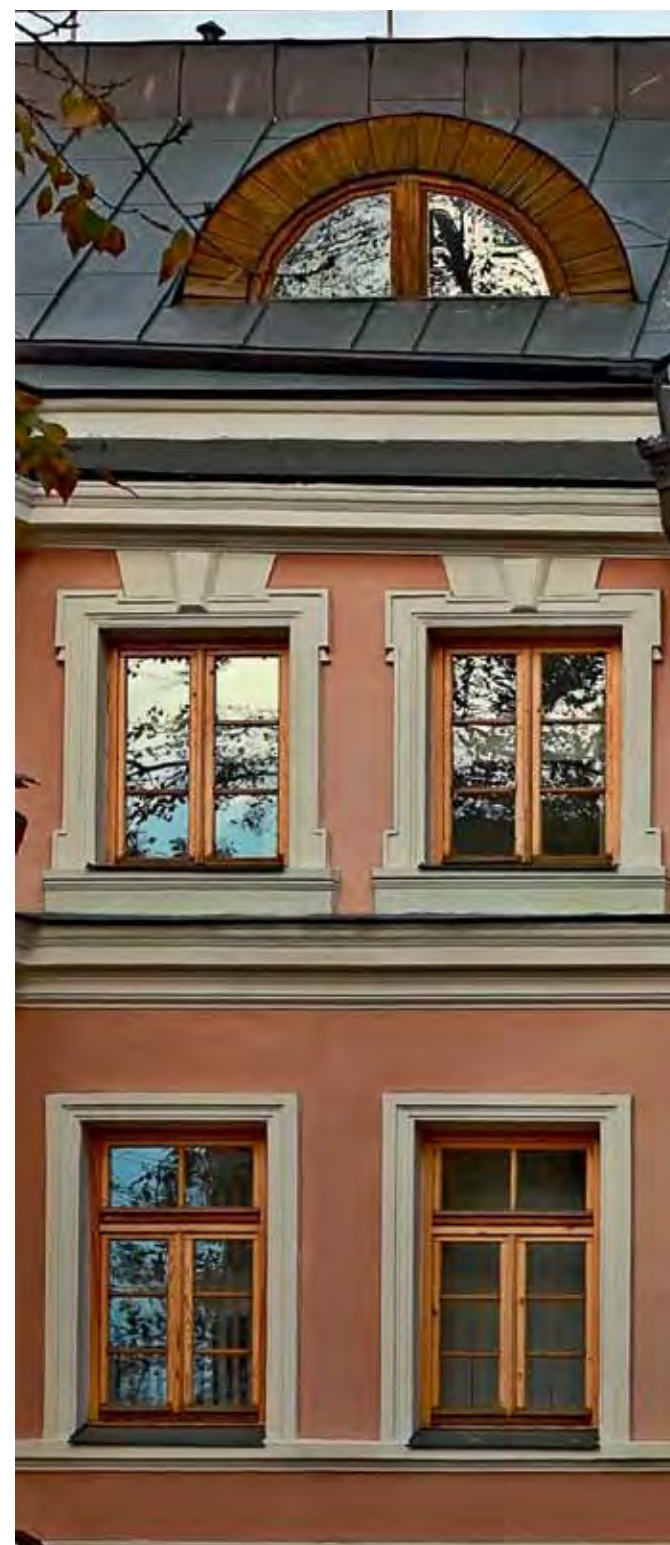
Фрагмент фасада с окнами после реставрации
