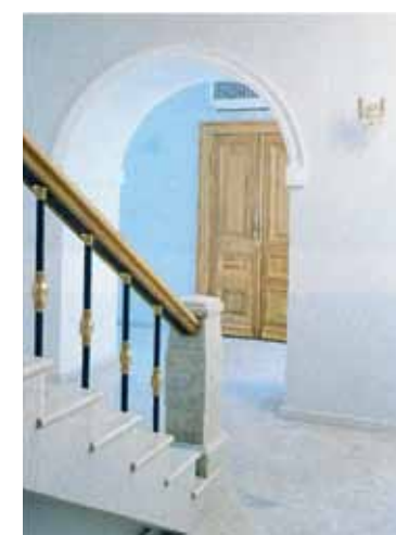
Деревянная и мраморная лестницы в интерьерах усадьбы после реставрации
