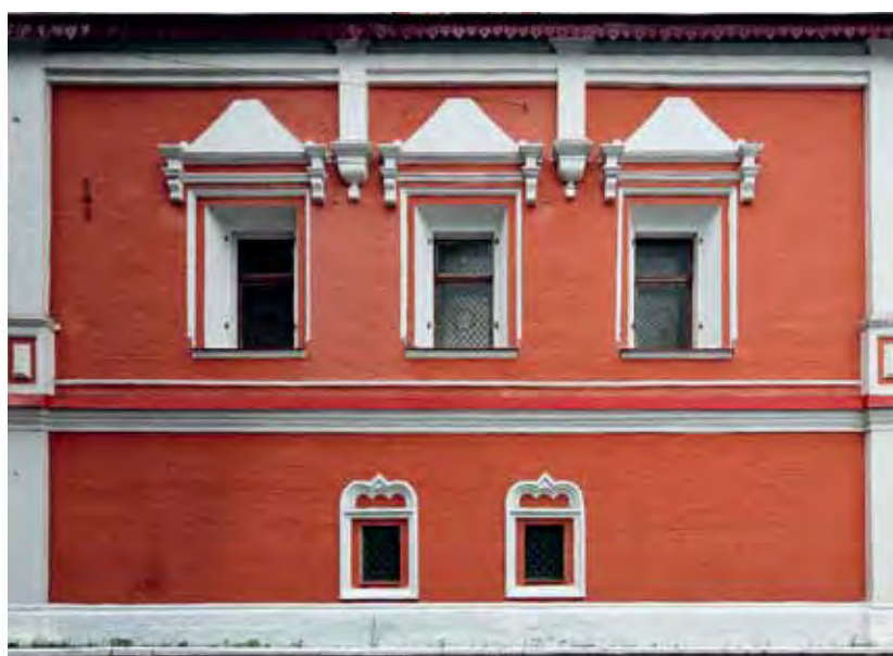
Окна боковых фасадов палат после реставрации.
