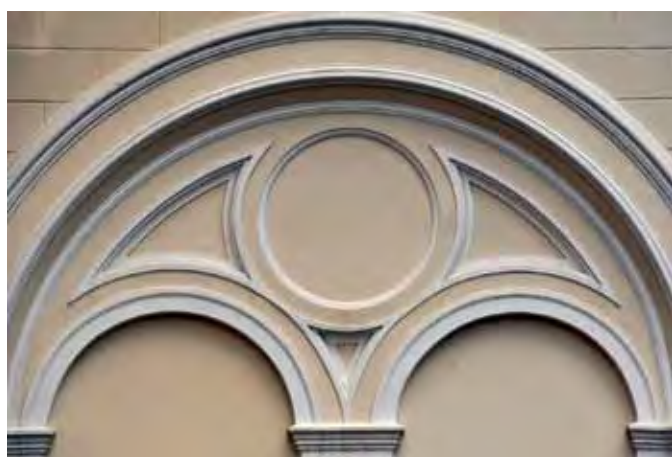
Элемент соборного декора после реставрации
