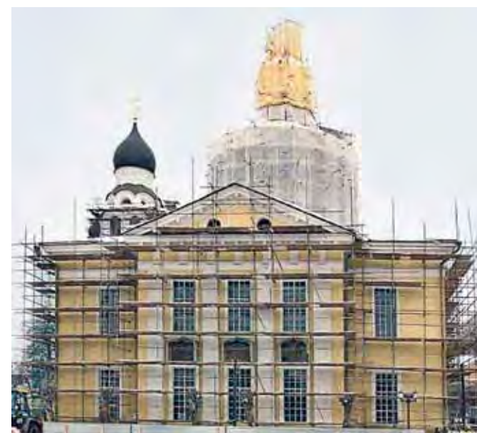
Собор в процессе реставрации
