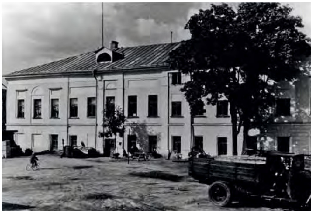
Дворовый фасад главного дома усадьбы. Начало XX в.
