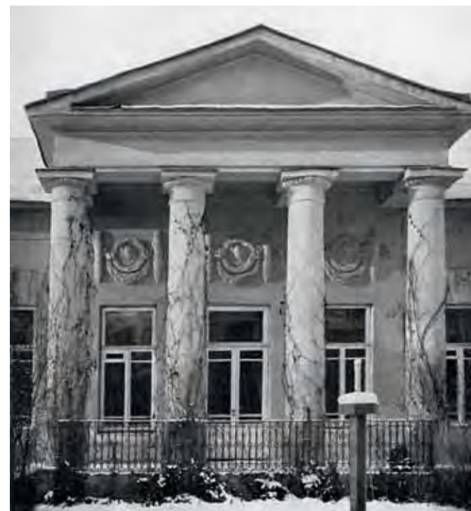
Фрагмент фасада с колоннами. 1900–1903 гг.
