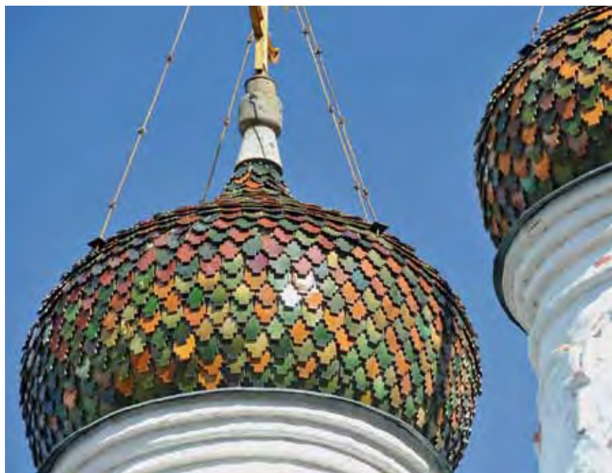
Вид на купола храма после реставрации
