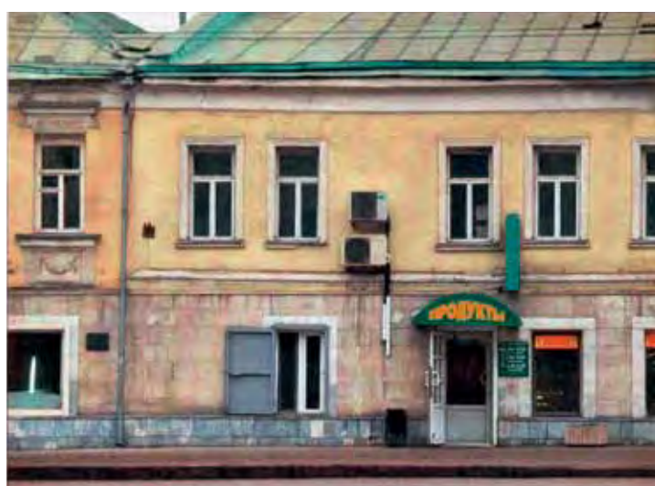
Фрагмент дома до реставрации. 2005 г.
