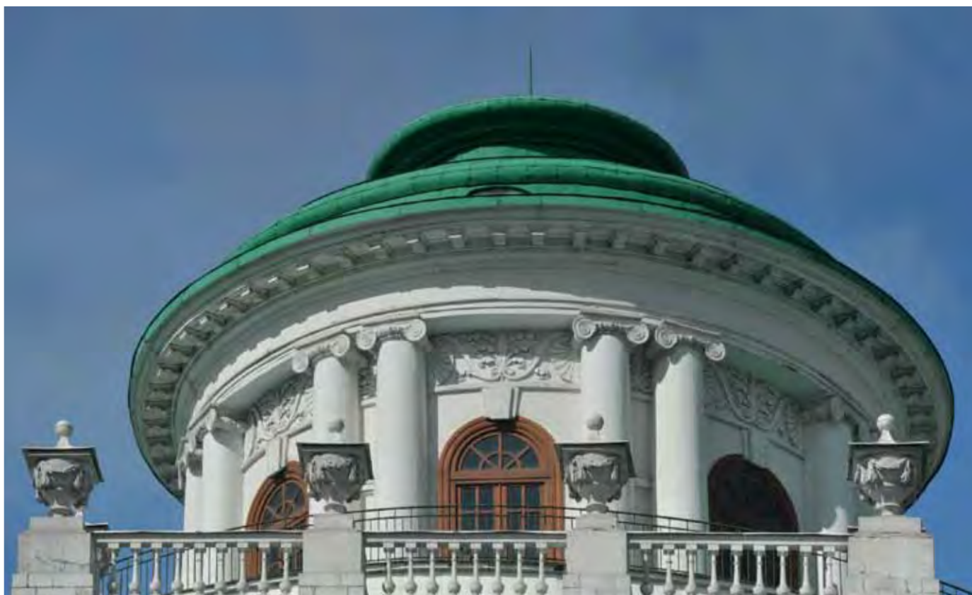
Бельведер дома после реставрации
