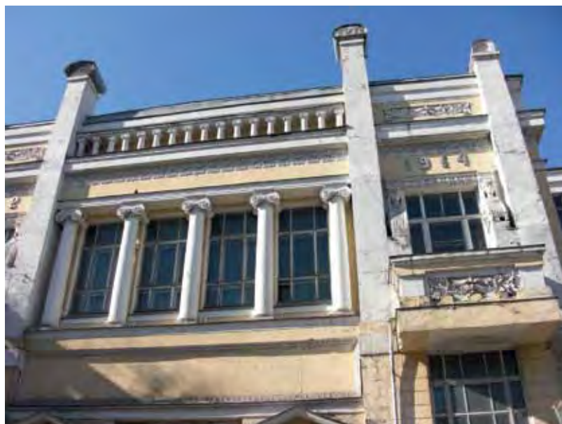
Фрагмент фасада одного из зданий до реставрации
