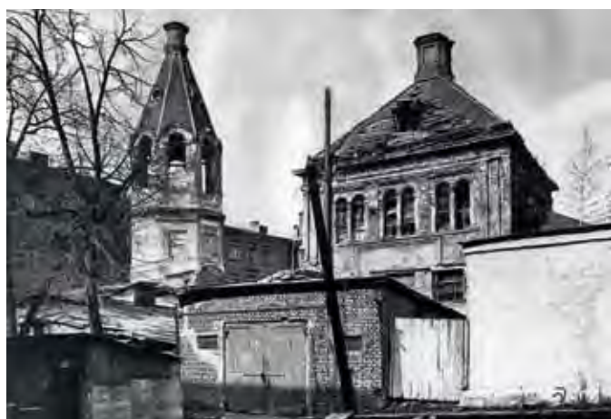
Церковь до реставрации. 1977–1979 гг. Вид с северо-запада
