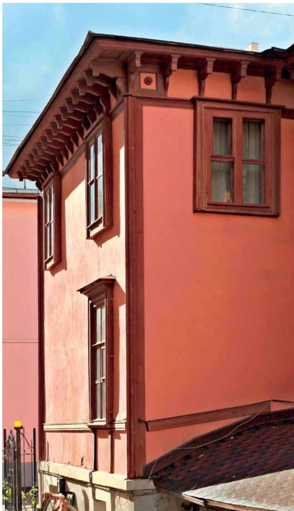
Фрагмент дворового фасада дома после реставрации
