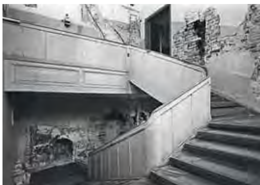
Парадная лестница в главном доме усадьбы до реставрации
