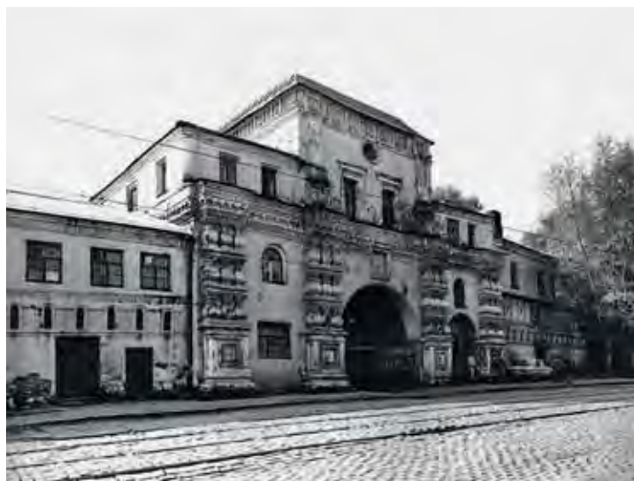
Надвратная церковь и колокольня Даниловского монастыря до реставрации. 1983 г.
