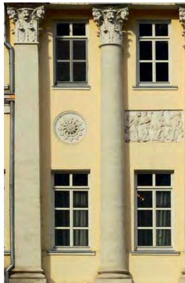
Фрагмент фасада усадьбы с колоннами и лепным декором после реставрации
