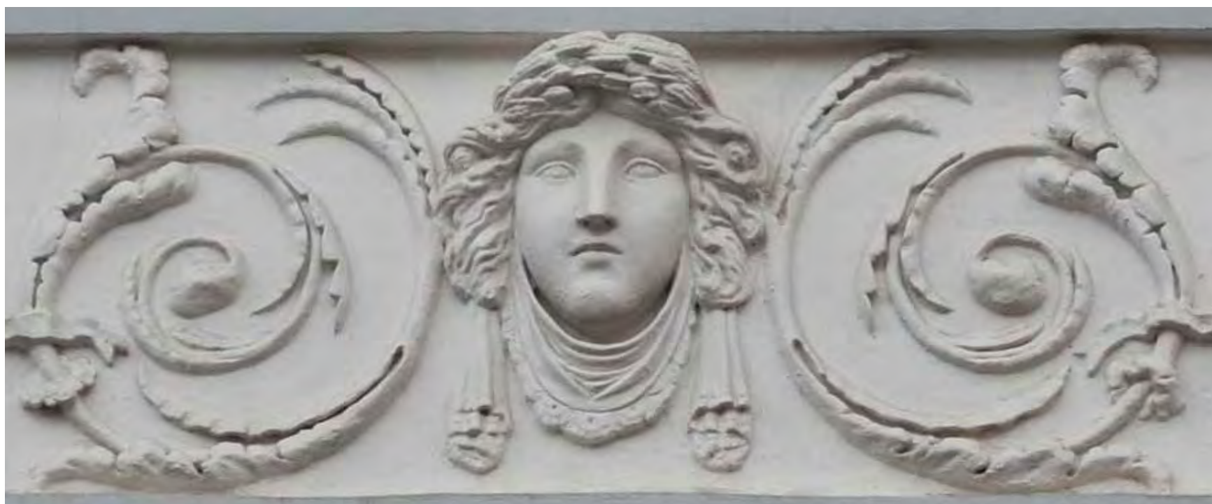
Лепной декор фасада после реставрации
