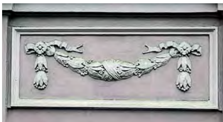
Окно и лепные элементы фасада особняка после реставрации
