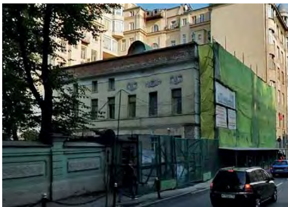
Городская усадьба в процессе реставрации
