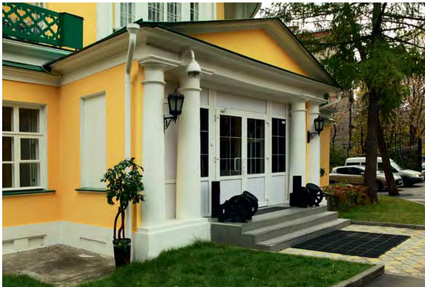
Главный вход в дом после реставрации
