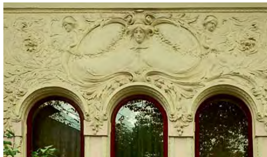
Фрагмент фасада особняка с окнами, декори- рованный лепниной, после реставрации
