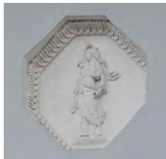
Фрагмент декора фасада после реставрации
