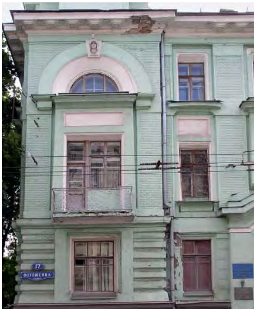
Доходный дом до реставрации. 1990-е гг.
