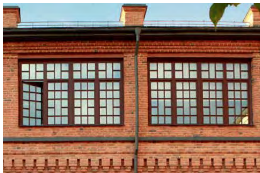
Фрагмент фасада завода с окнами после реставрации
