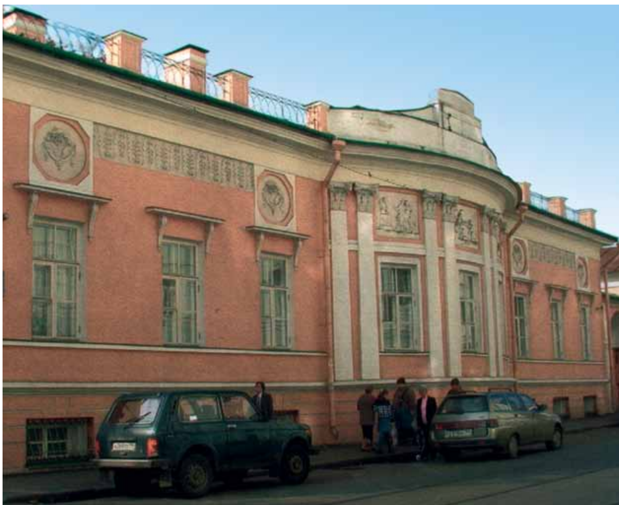
Вид на главный дом усадьбы до реставрации
