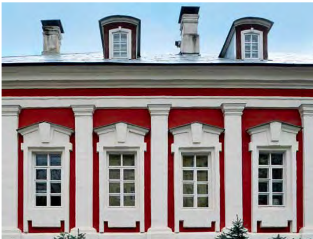
Окна второго этажа усадьбы после реставрации
