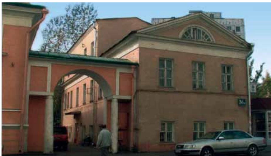
Северный флигель усадьбы с аркой до и после реставрации
