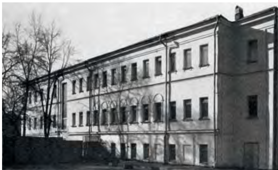
Вид на фасад дома драматурга К. А. Тарновского. 1970–1979 гг.
