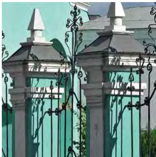
Ограда храма после реставрации
