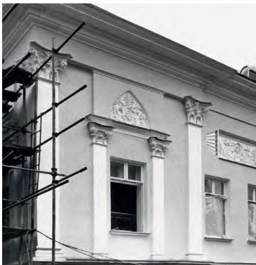
Фрагмент фасада здания с окном и лепным декором в процессе реставрации
