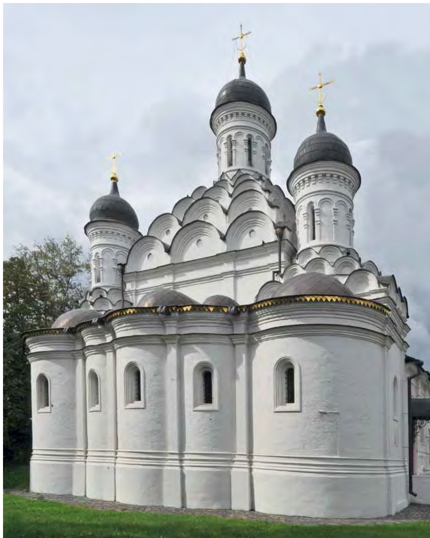
Вид церкви после реставрации
