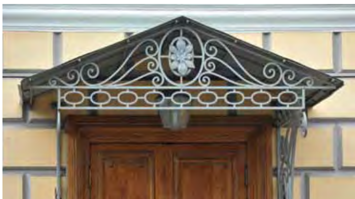
Элементы кованого и лепного декора фасада после реставрации
