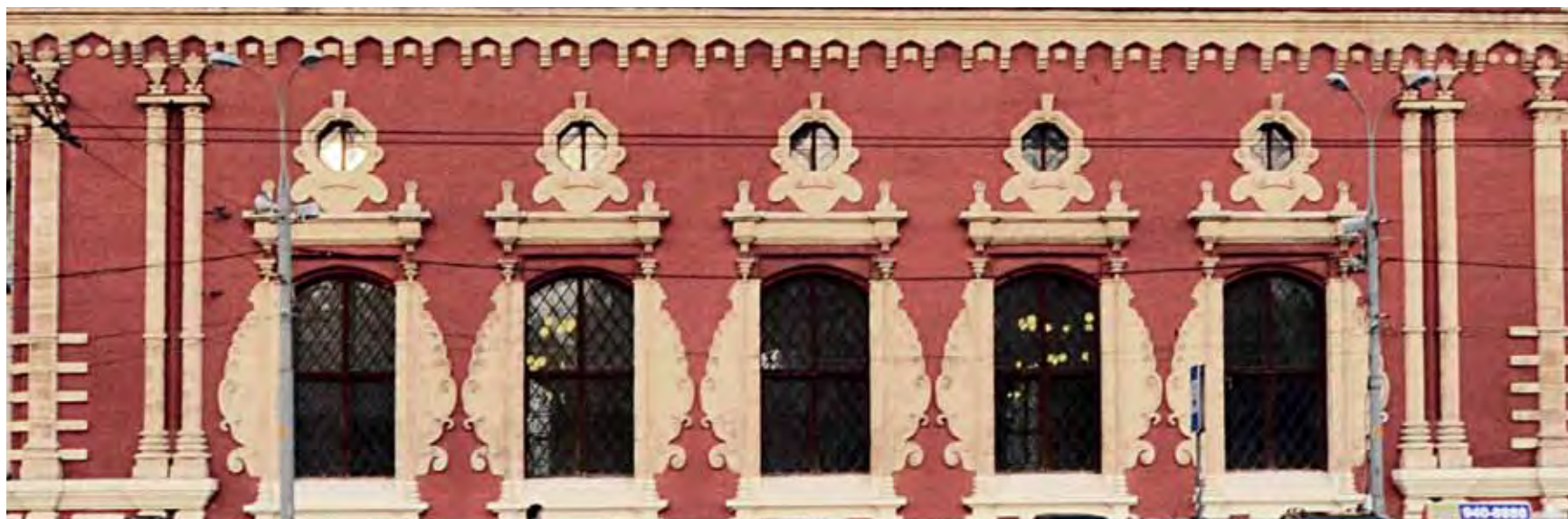
Фрагмент фасада вокзала с окнами после реставрации
