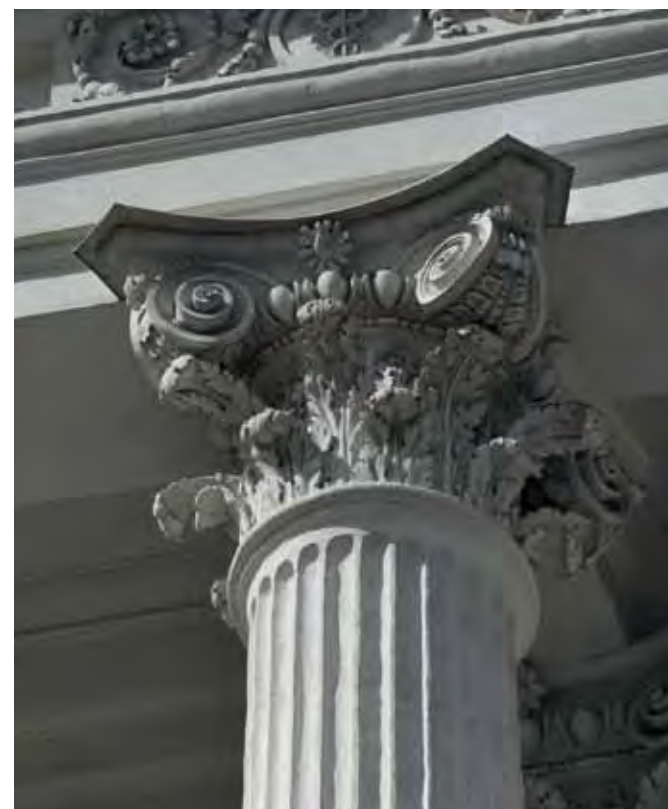
Капитель колонны после реставрации
