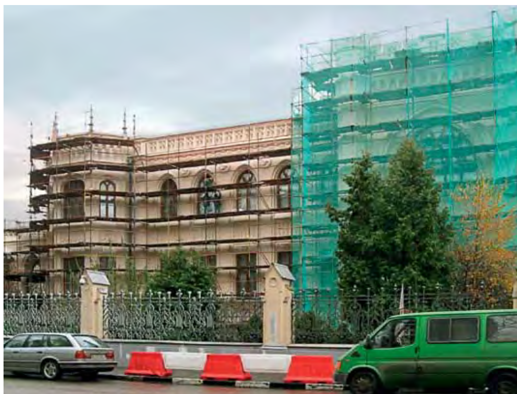
Особняк З. Г. Морозовой в процессе реставрации
