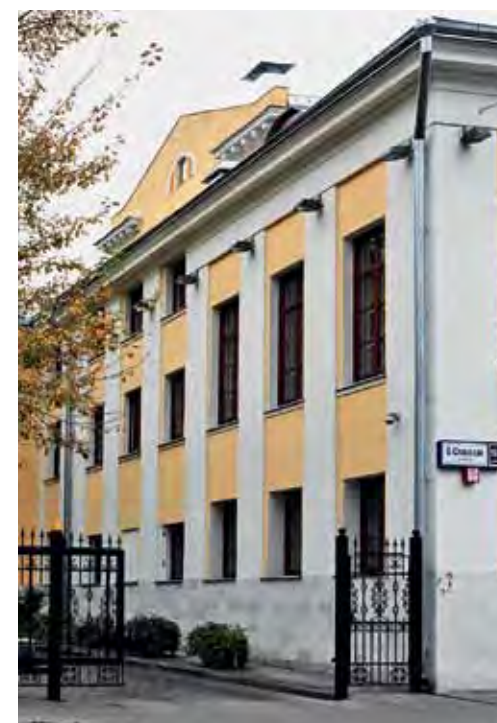
Вид на фасад здания со стороны двора после реставрации
