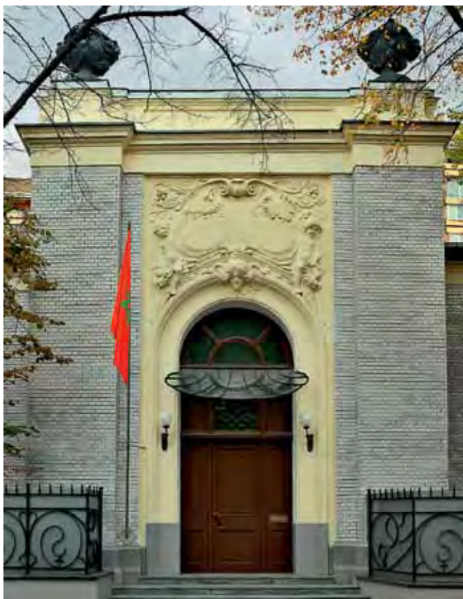
Парадное крыльцо особняка с козырьком после реставрации
