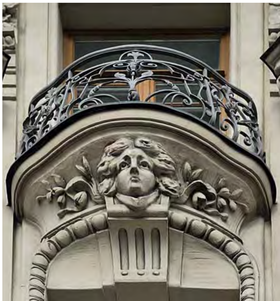
Фрагменты фасада гостиницы с ажурными балконами после реставрации
