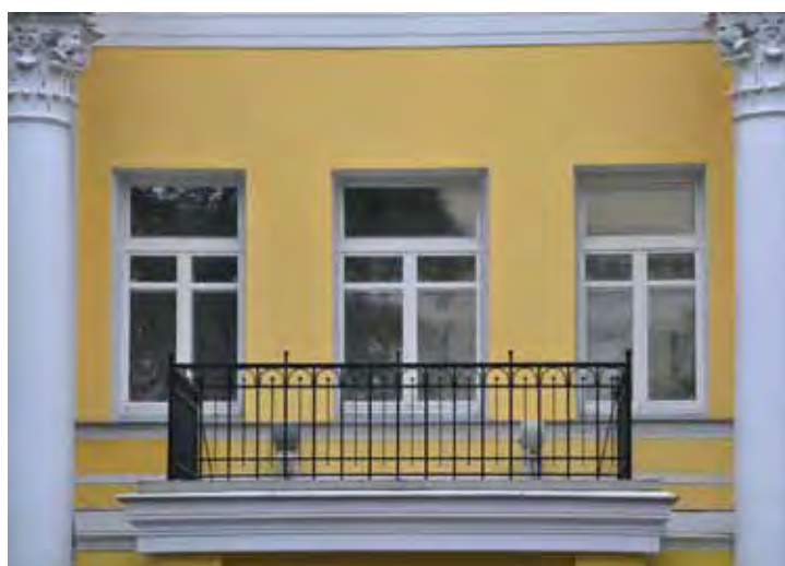
Балкон усадьбы после реставрации
