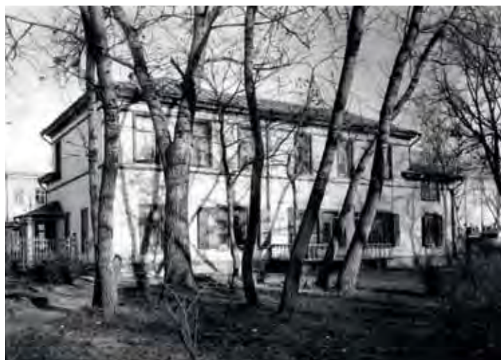
Вид на дом-усадьбу из сада до реставрации
