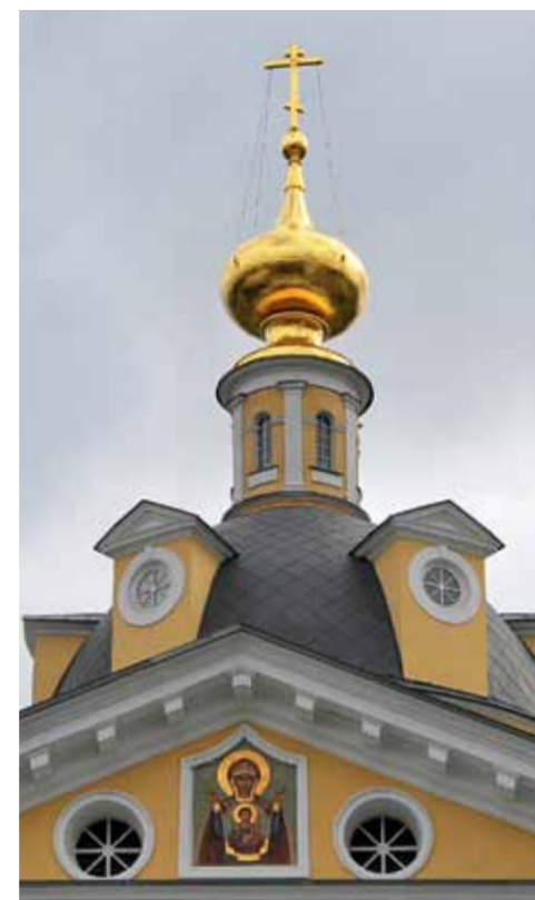
Фрагмент купола собора после реставрации
