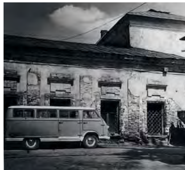
Фрагмент южного фасада храма до реставрации. 1968 г.
