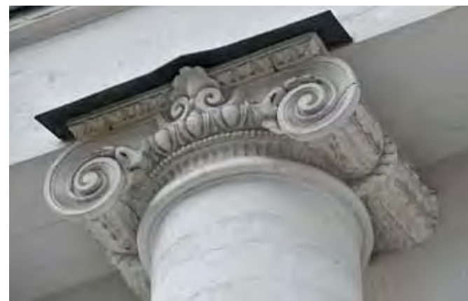
Капитель колонны храма (ионического ордера) после реставрации
