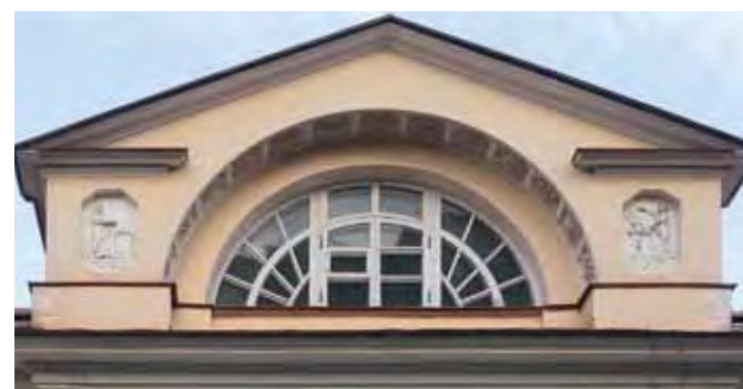
Фрагменты крыши и фасада дома после реставрации
