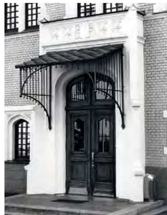
Крыльцо главного входа до и после реставрации
