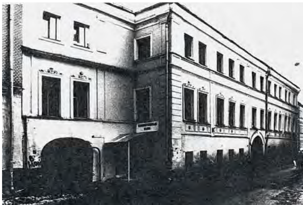
Главный фасад дома до реставрации. 1991 г.
