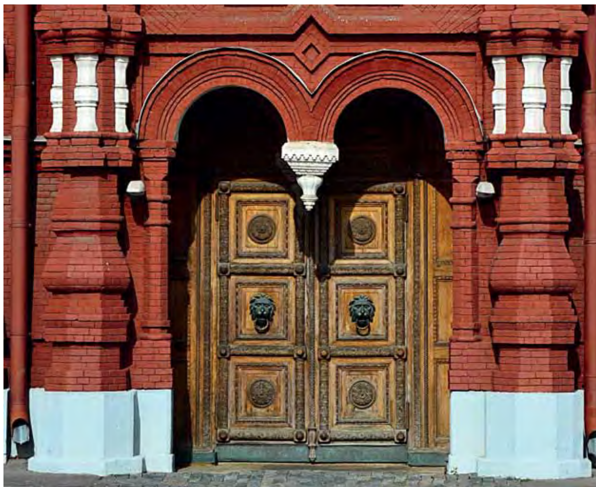
Фрагмент фасада музея со входом после реставрации
