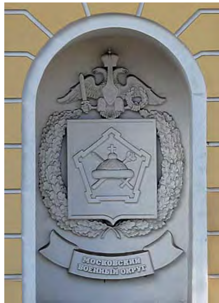
Фрагмент фасада здания после реставрации
