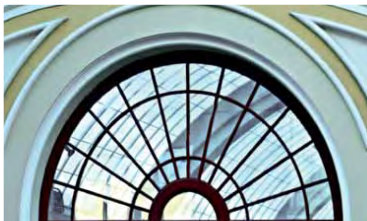
Фрагменты фасада пассажа с окнами и декоративной колонной после реставрации
