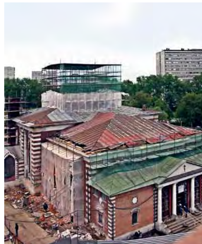
Общий вид церкви в процессе реставрации
