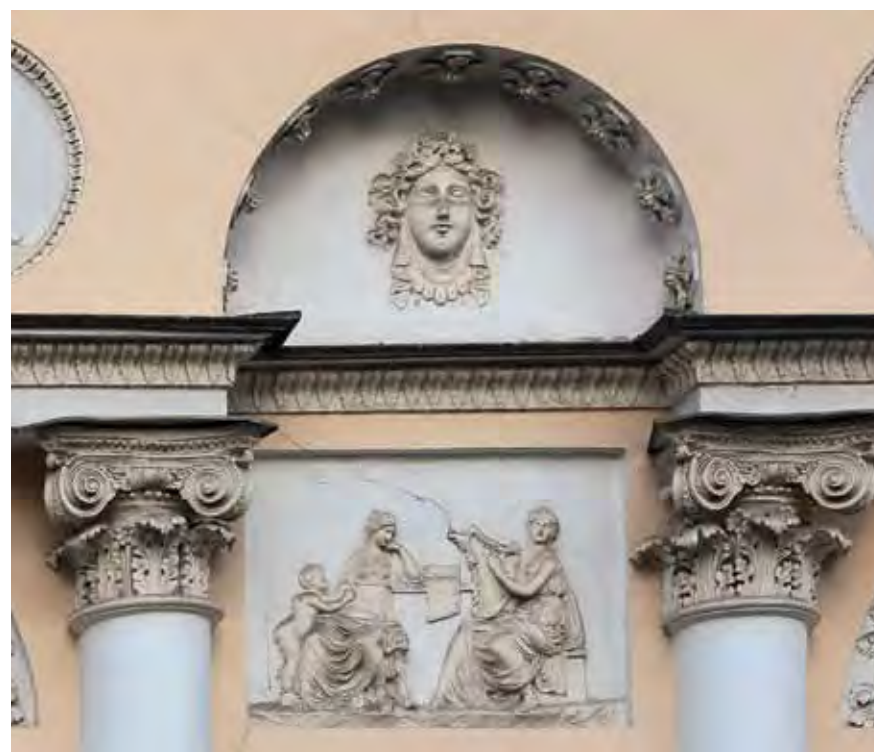
Окна с декоративными колоннами и лепной декор фасада после реставрации
