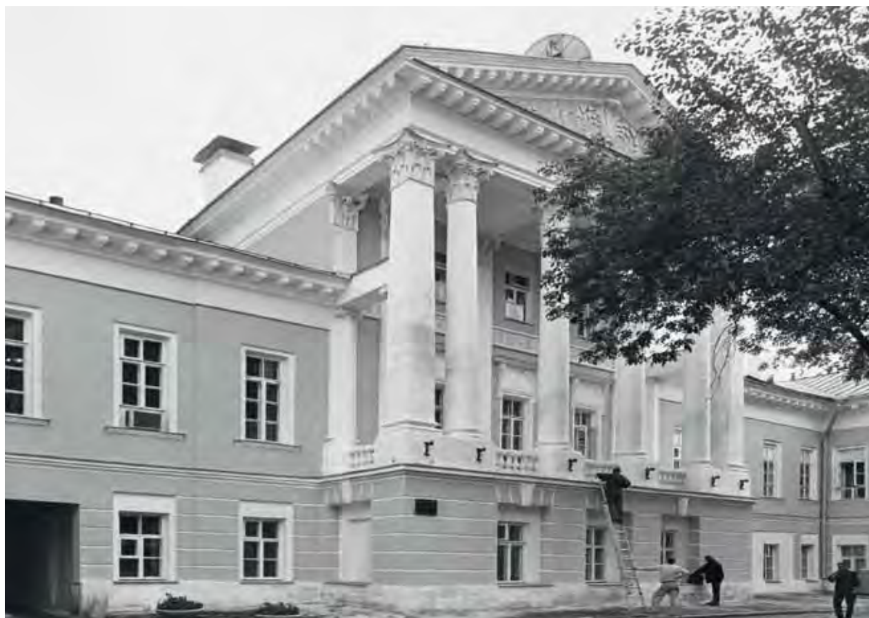
Фрагмент фасада дома с портиком в процессе реставрации
