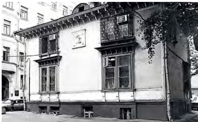
Боковой фасад дома до и после реставрации
