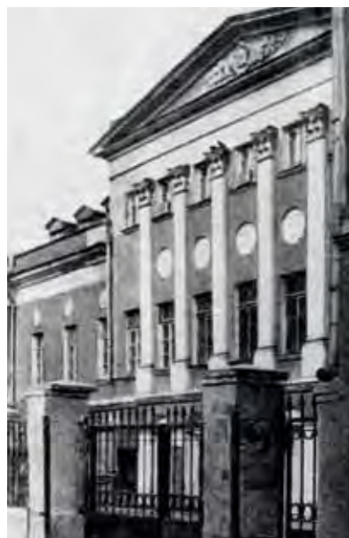
Вид на один из фасадов дома до и после реставрации
