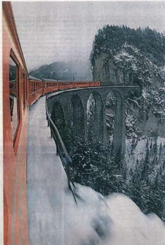
Das Landwasseriadukt bei Filisur ist ein Paradestück der Rhätischen Bahn
