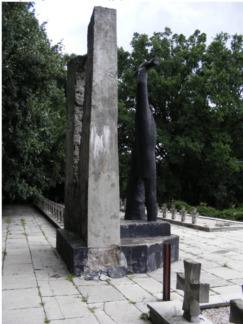
Pomnik „Powstanie” cmentarz wojenny przy ul. Piaskowej w Puławach stan przed pracami restauracyjnymi
