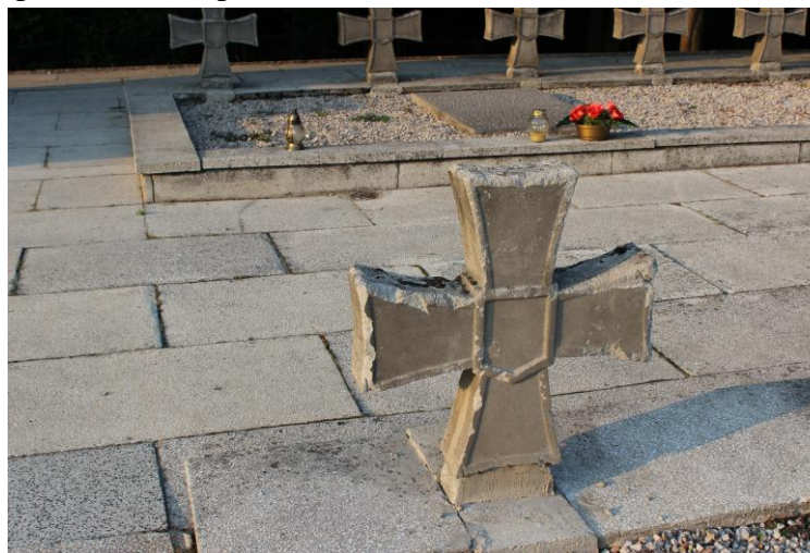
po remoncie lipiec 2012 r.
