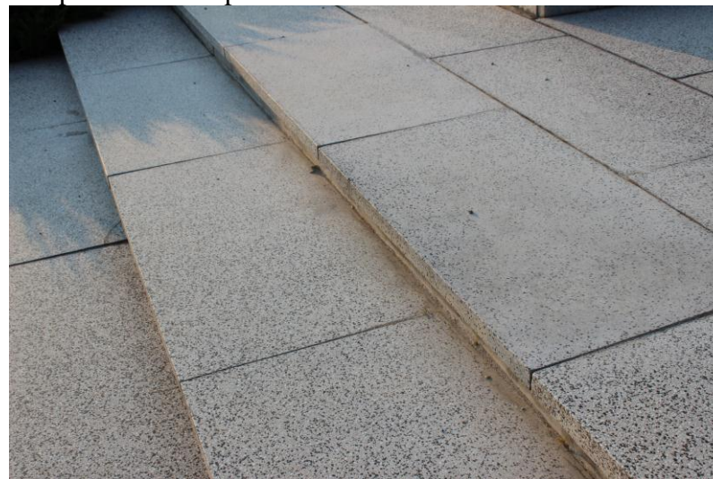
po remoncie lipiec 2012 r.
