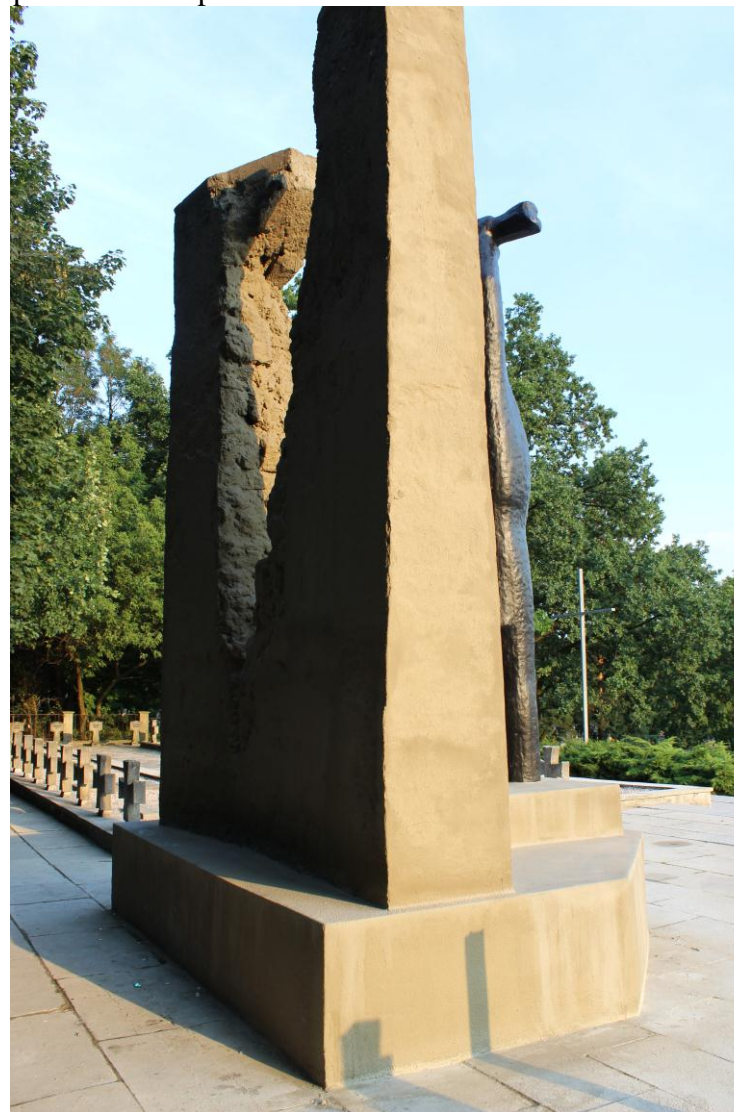
po remoncie lipiec 2012 r.
