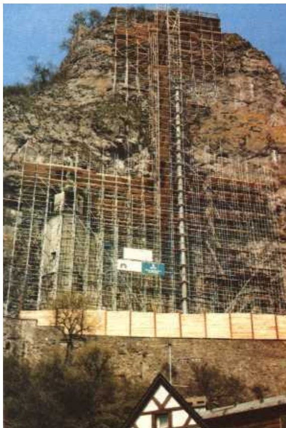
Bild 63: Europas höchstes Arbeitsgerüst, 1980
