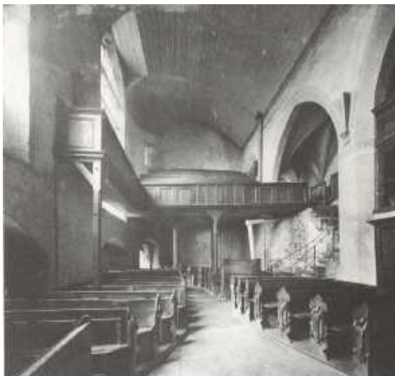
Bild 36: Die (Bretter) Tonnendecke im Hauptschiff von ca. 1750 – 1927
