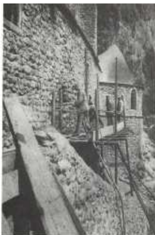
Bild 4: Burg oder Kirche? Schildmauer und Sakristei während der Sanierungsarbeiten 1928
