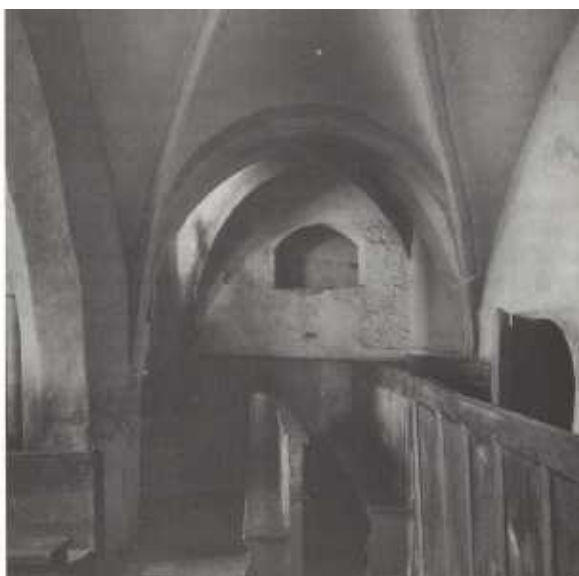
Bild 16: Seitenschiff mit ehemaliger Nische während der Umbauarbeit 1929
