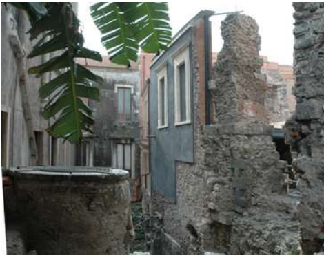
Prospetti di XVIII e XIX secolo costruiti sul muro perimetrale orientale del teatro
