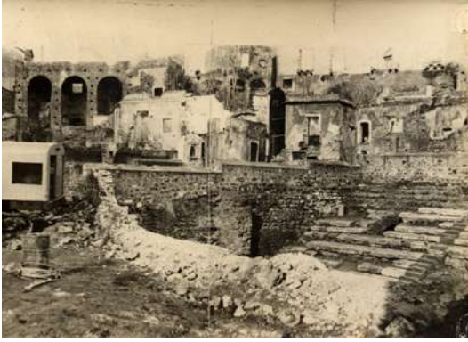
Tratto superiore di via Grotte prima della sua demolizione (1962)
