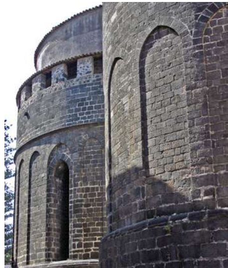
Cattedrale di Catania. Blocchi lavici antichi nel muro esterno delle absidi normanne
