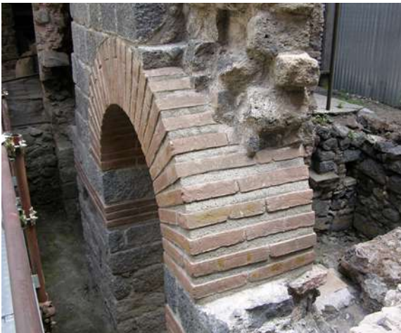
La parete est della paraskéné orientale dopo il restauro di una delle arcate (2000)
