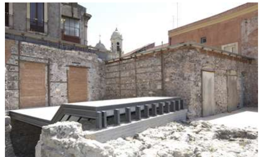
Muri a graticcio sopra della "casa del terremoto"
