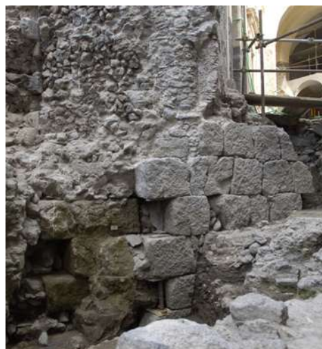
Muro della fase greca del teatro in fase di scavo (2007)
