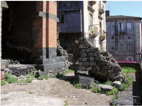
Un tratto del fornice abbattuto
